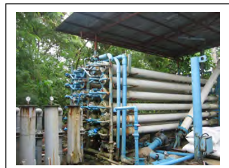
写真-6 Mactan Rock 社の膜処理
