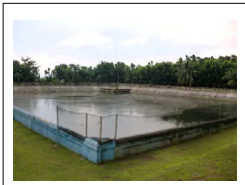
写真-4 Tisa 浄水場（緩速ろ過池）
