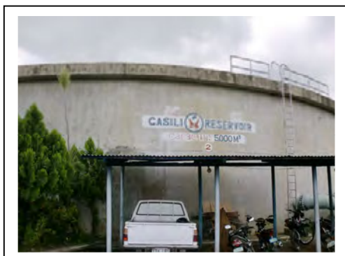
写真-2 Casili 2 配水池
