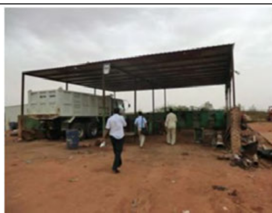
ウンバダ郡の既存ワークショップ 駐車場程度の施設で整備機材もほとんどなく、十 分な整備ができていない。
