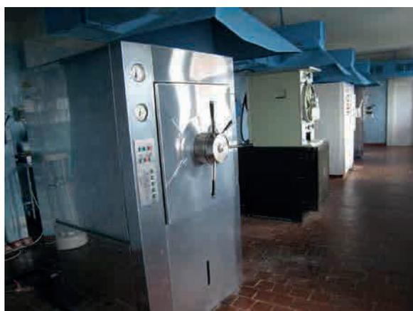
手術部に隣接している中央滅菌室。機材はすべて片扉タイプでメンテ側とオペレータ側が仕切られていない。
