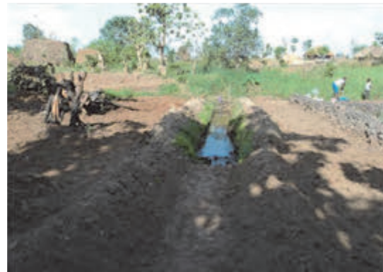
ため池下流で溝を掘り地下水を得ている。浅井戸の変形とみられた（イエイ）。
