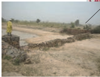
ワジに仮設フトンカゴを積んで洪水期のリセセッション灌漑農業も検討される。
