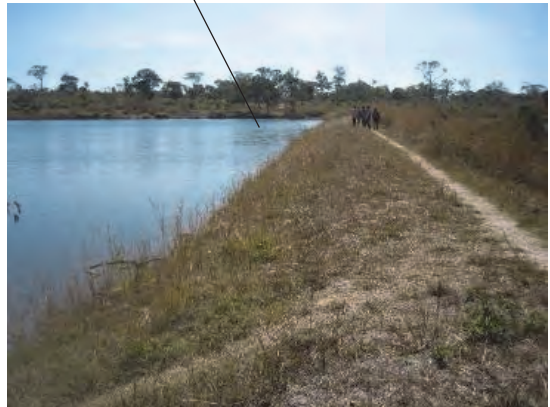
中規模なため池建設による灌漑スキームの建設
