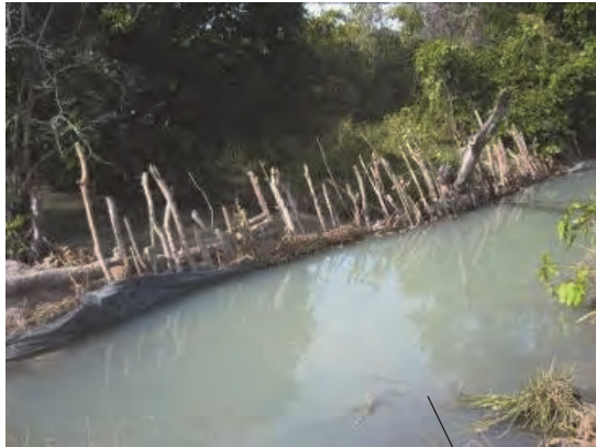
農民の建設による簡易な取水堰を導入した灌漑スキーム
