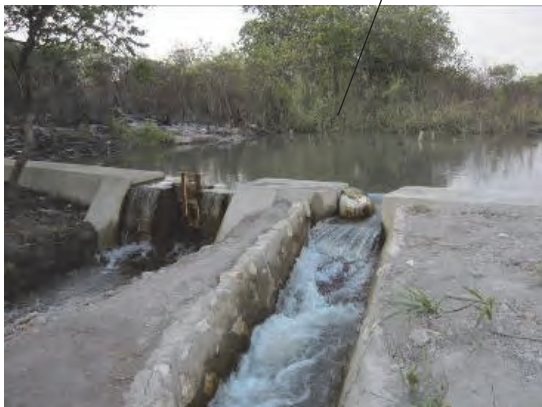
農民の建設・維持管理による中小規模のコンクリート製取水堰を導入した灌漑スキーム
