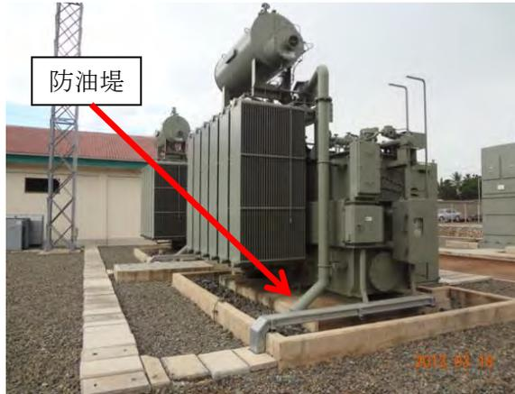
図 2-2-3-1.9 変圧器下の防油堤
