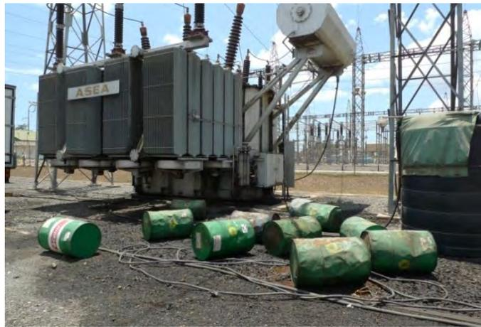
図 2-2-3-1.5 防油堤が設置されていない
