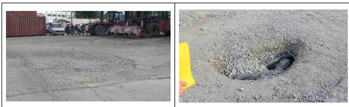
図 1.2-5 舗装と排水管の損傷による陥没個所
