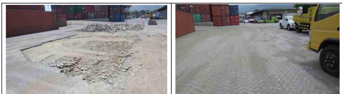
図 1.2-6 西コンテナヤードにおける ILB 舗装の改修途中と完了
