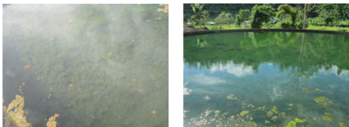
図 1-1-4 Alaoa 浄水場の砂ろ過池状況
