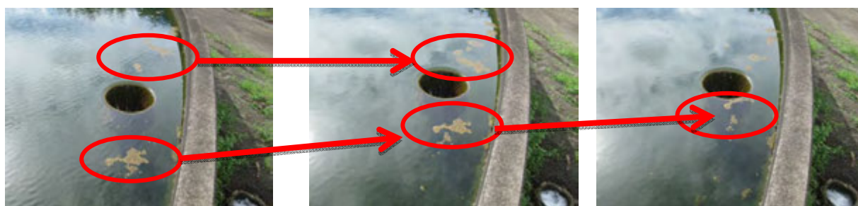
図 3-2-10 越流管の状況
