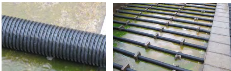
図 3-2-13 ろ過池底部の敷設状況
