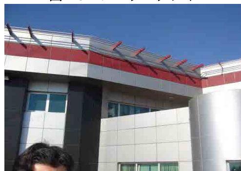
図 7-5 高断熱外壁パネル
