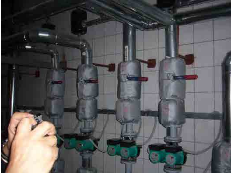
図 7-7 バルブおよびパイプの断熱
