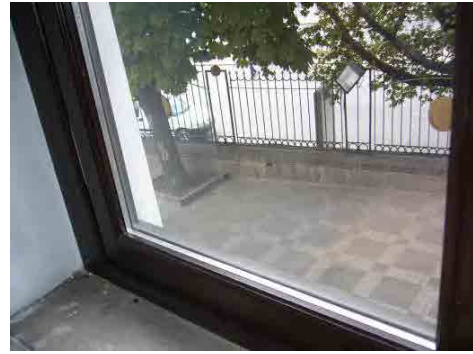
図 7-6 Low-e ペアガラス+断熱サッシ
