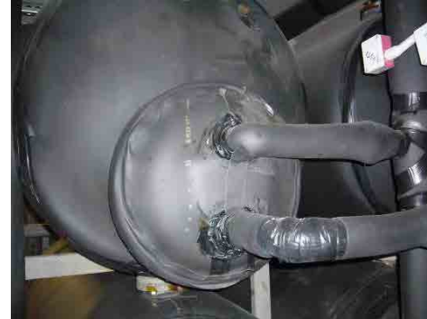
図 7-8 高温水タンク、ボイラの断熱
