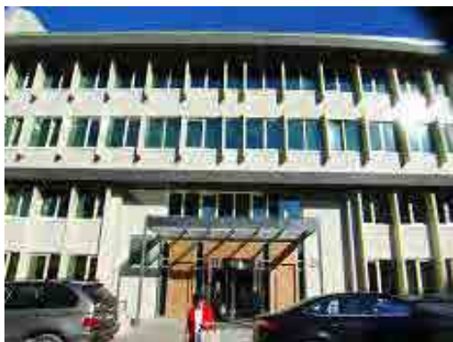
図 7-1 日よけ、高断熱壁、反射ガラス
