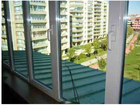
図 7-6 Low-e ペアガラス+断熱サッシ
