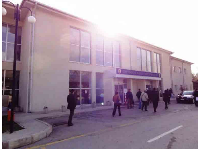
図 6-1-2 EM 病院外観
