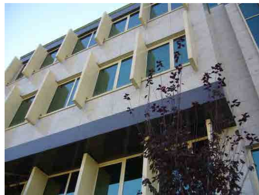
図 7-1 日よけ、高断熱壁、反射ガラス
