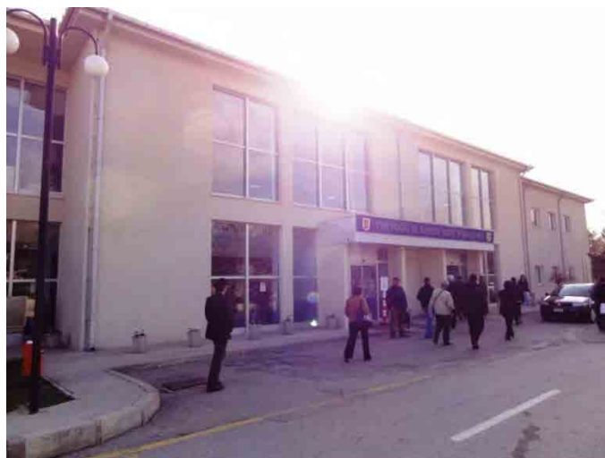
図 2.3.2-2 EM 病院外観
