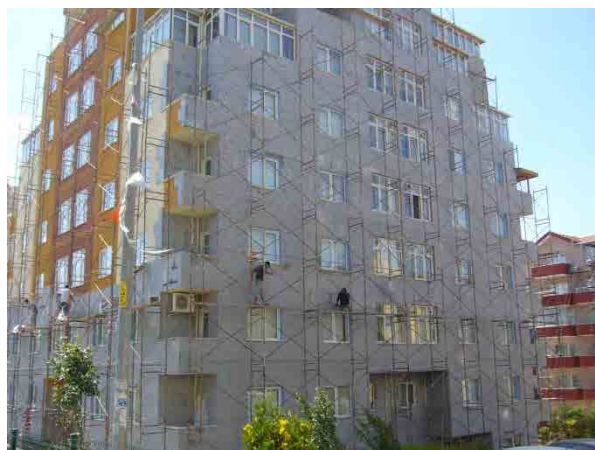
図 2.3.3-2 既存建物の断熱改修工事現場
