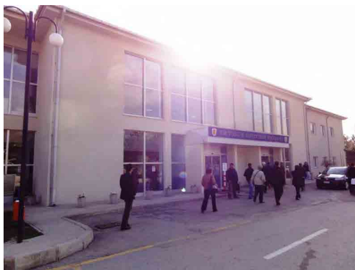
図 2.3.2-2 EM 病院外観
