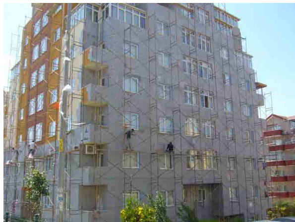
図 2.3.3-2 既存建物の断熱改修工事現場
