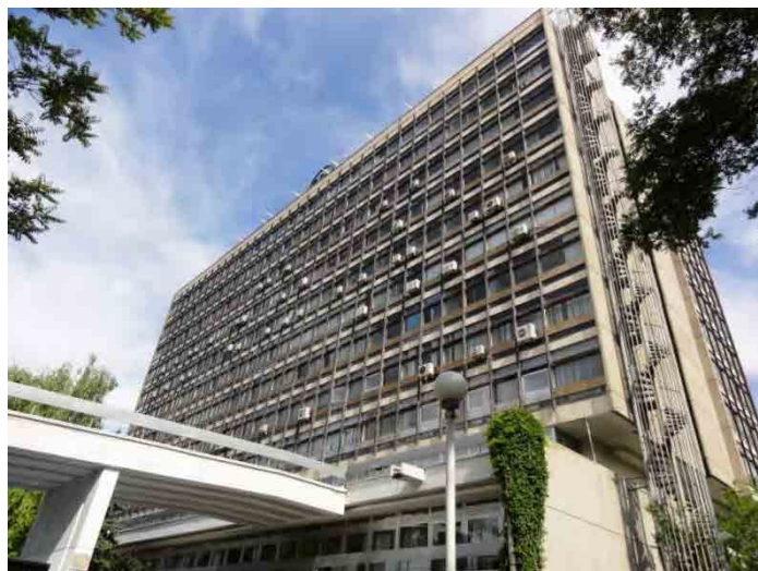
図 2.3.2-1 DSI ビル外観
