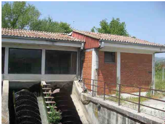
スクリーポンプを用いた揚水機構
