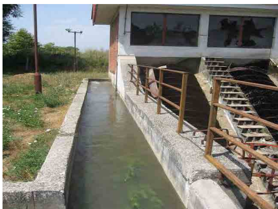
緊急バイパス放流水路 出典：JICA 調査団
