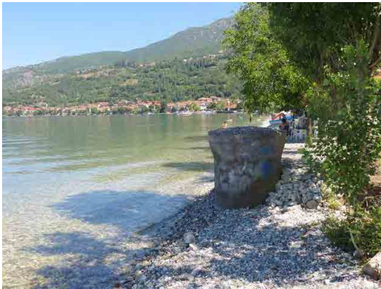
湖岸に設置されたマンホール
