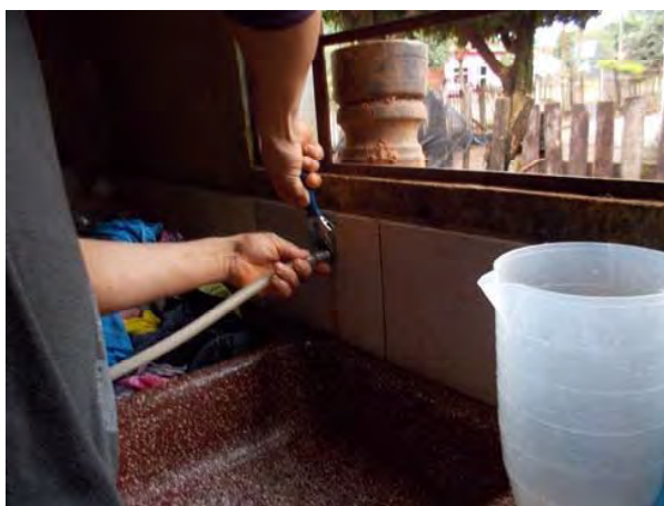
設置No.5 洗濯場の蛇口をはずして耐圧ホースを設置
