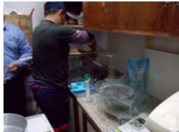
設置No.4 台所の蛇口をはずして耐圧ホースを設置
