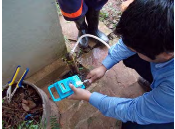
設置No.7 耐圧ホースと水圧データロガー本体を接続
