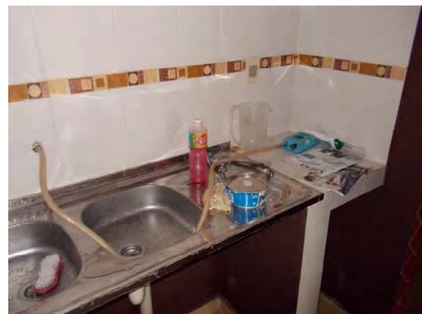
設置No.8 屋内での水圧データロガー設置状況
