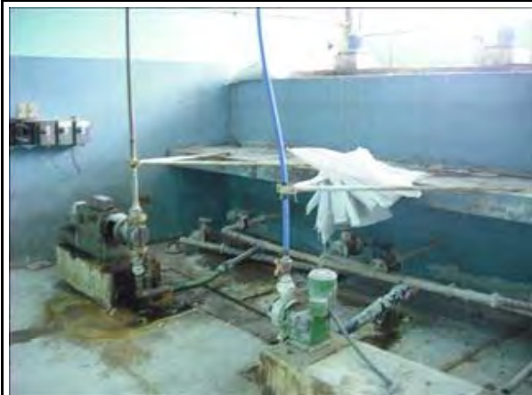
No.9 硫酸アルミニウム溶解施設
