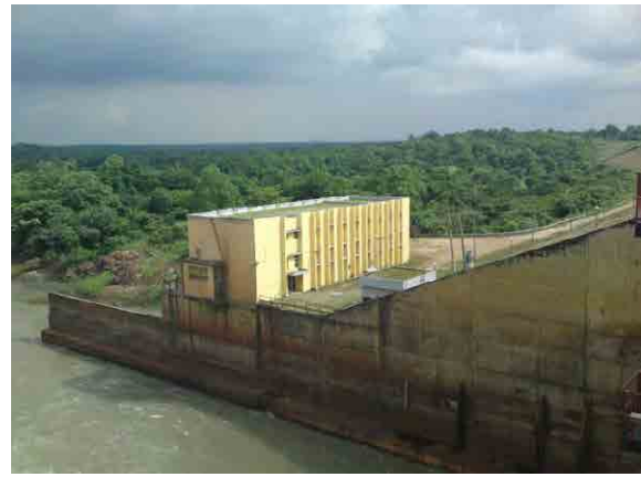
写真 7-2 Oyan ダムの水力発電設備 (使用されていない)
