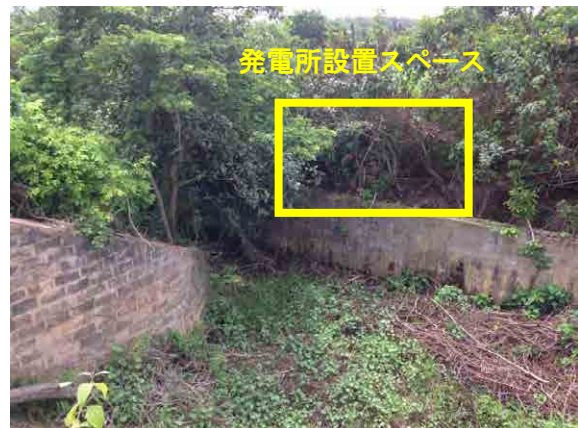
写真 7-4 RBDA 内に設置してある ダムの余水吐き下流
