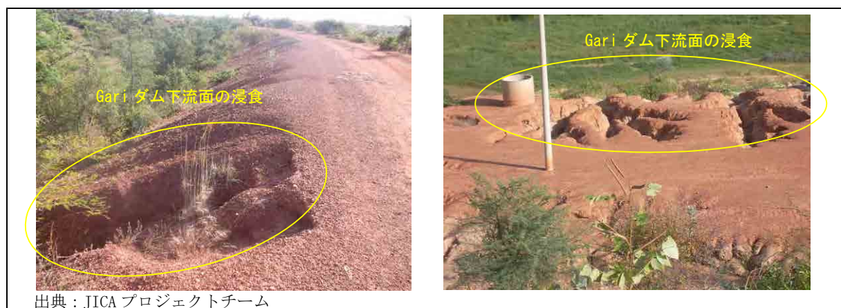
写真 8-2 Gari ダム堤体の浸食状況
