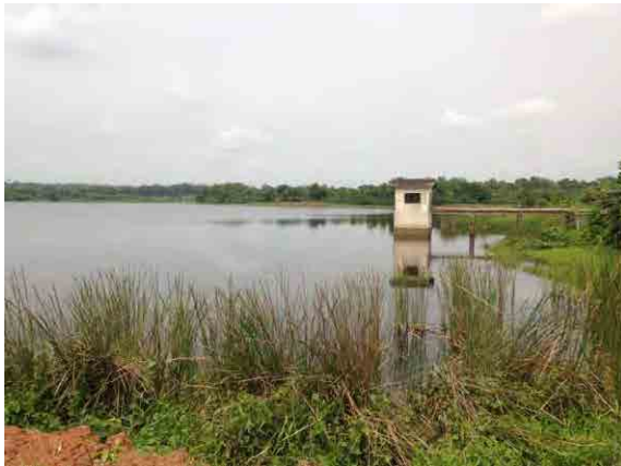
写真 7-3 RBDA 内に設置してある ダムの貯水池と取水設備
