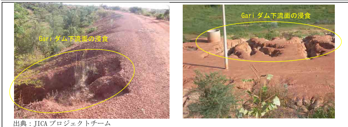
写真 8-1 Gari ダム堤体の浸食状況
