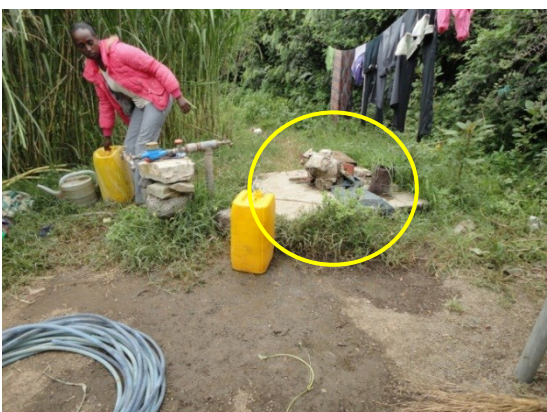
⑧ Awash Melkasa 町の 2 本目井戸。10 年前に World Vision が完成後、ケーシング崩壊事故で廃止された。
