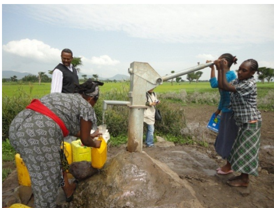
⑤ Ude-Dhankaka 町の畑地。20 年以上前からある手掘り井戸にハンドポンプを設置した。水委員会が管理。
