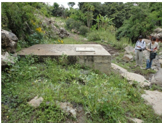
① Sire 町の水道水源(湧水をコンクリート Box で保護)。近くの送水ポンプで配水池へ送っている。
