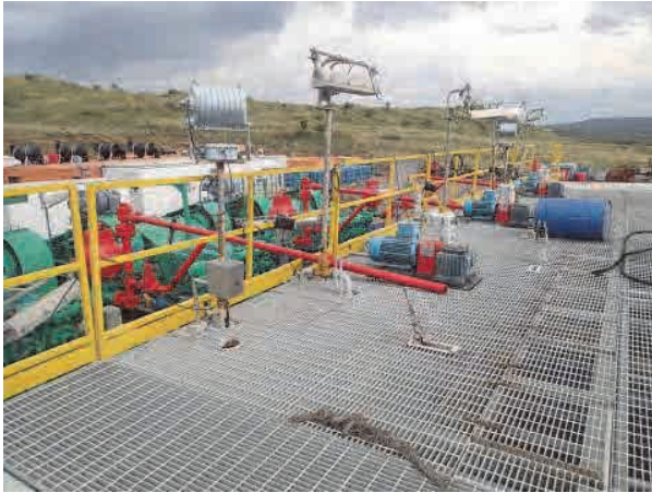
泥水ポンプの高圧配管のリリーフバルブ排出口
