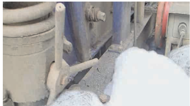
サンドシェーカーにて分離され泥水タンクに落ちている水分
