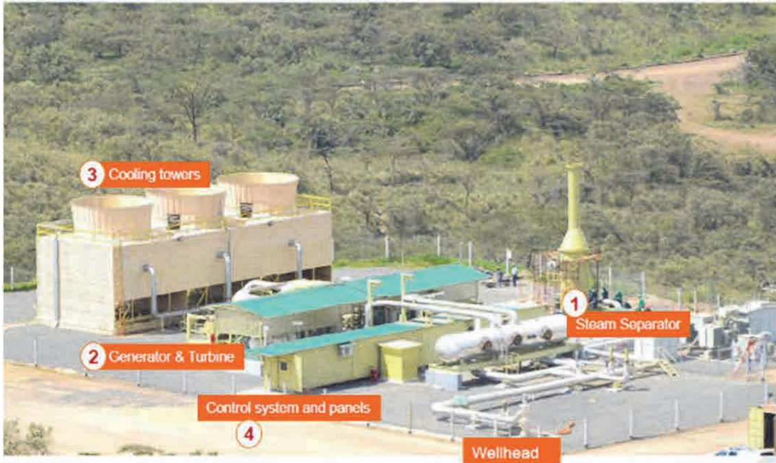
図 2-6 オルカリアで稼働中の井戸元発電
