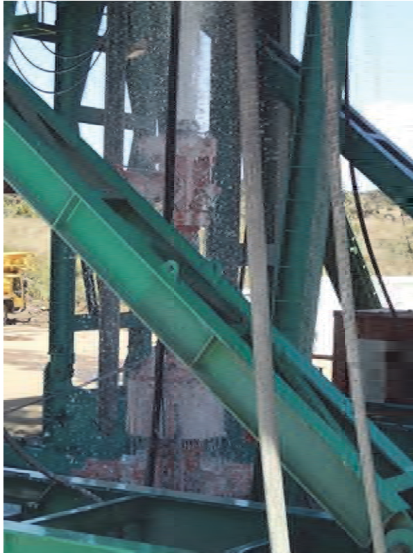
ローテティングヘッドより吹き出ているフォーム掘削水
