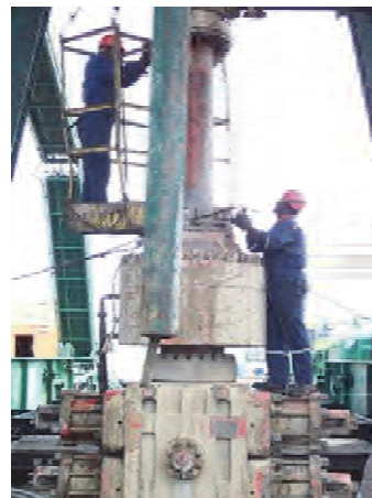
不安定なゴンドラにおける作業
