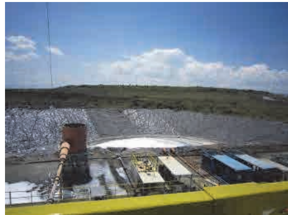
地熱井戸掘削汚泥の貯水池（白い泡がフォームドリリングの泡）
