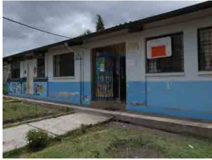
既存カルピ SCS
