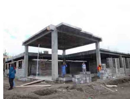
ラッソ CS (C タイプ) 保健省作成の CS 基準図面通りに建設中である。2013 年 5 月竣工予定だが、工事は遅延していた。
