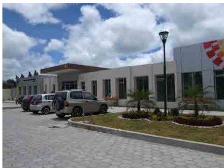
ローマ・グランデ CS (A タイプ) 保健省作成の CS 基準図面通りに建設されたものである。2013 年 2 月に開院した。
