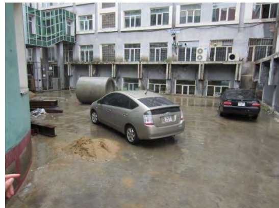
写真 新築実験棟予定地
