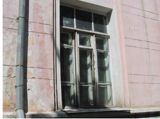
写真 改修されていない開口部（国立大学 6 号棟）
