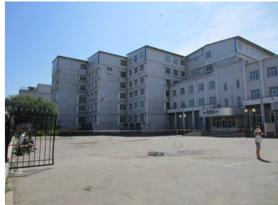
写真 2号棟 (駐車場より)
