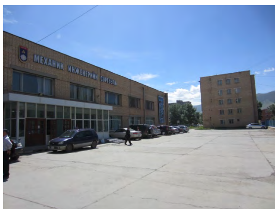
写真 1号棟（駐車場より 奥は学生寮）
