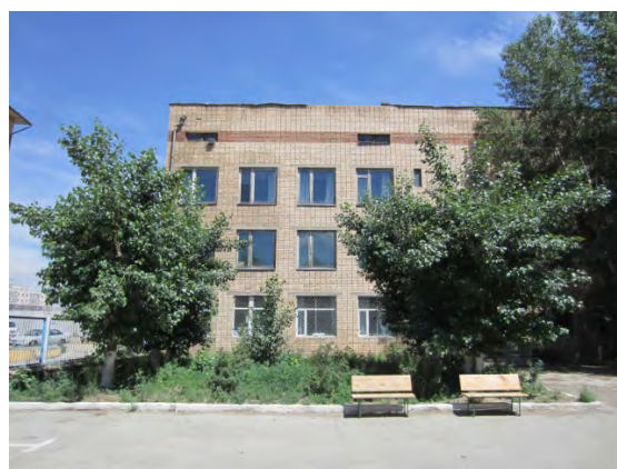
写真 2号棟（駐車場より）
