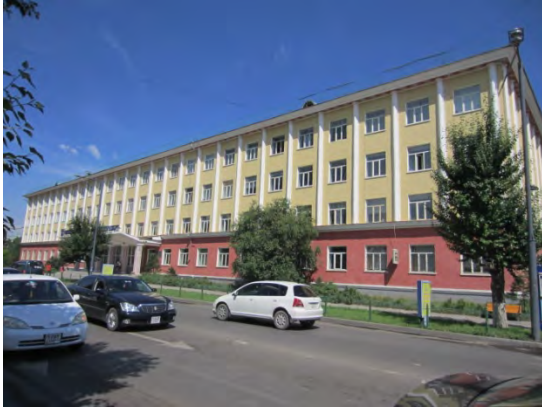
写真 2号棟南面 南面道路より
