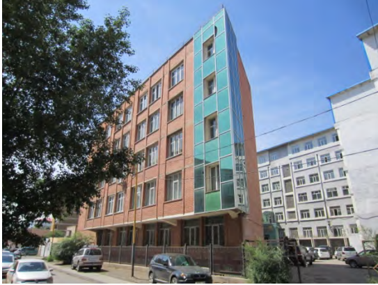
写真 T棟（手前）
