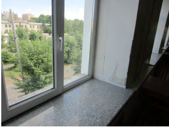
写真 改修済みの開口部（科学技術大学 2 号棟）
