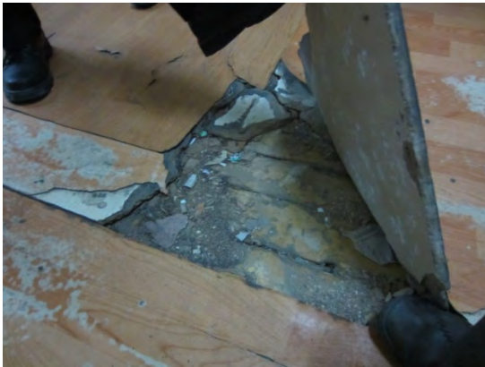
写真 古い床の上にシートを敷いている
