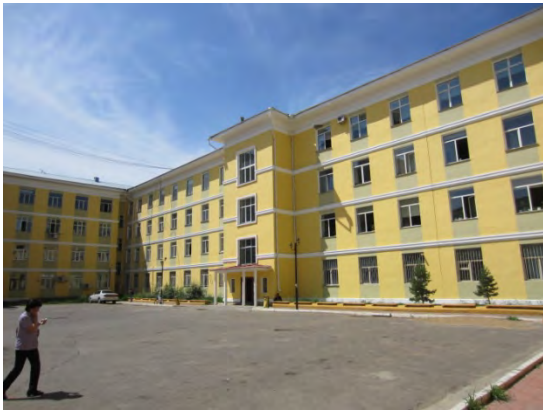
写真 1号棟 (中庭より)
