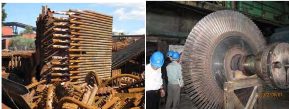
13号ボイラ、100%チューブ取替 解体され屋外に置かれたチューブ類
