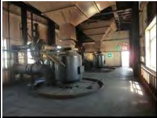
図 4-32 乾留炉上部石炭投入箇所
