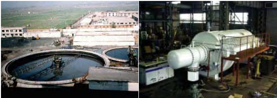
図5-10 排水シクナ（左）及び脱水装置（右）
