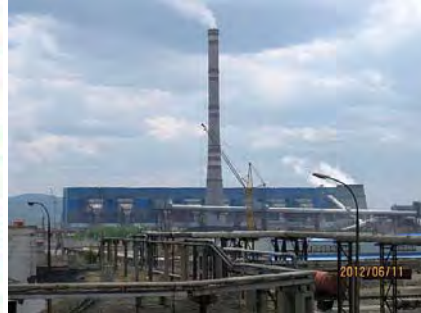
図 4-8 第 4 発電所ボイラ建屋側の全景 (第 2 発電所から撮影、手前は工場用蒸気配管)
