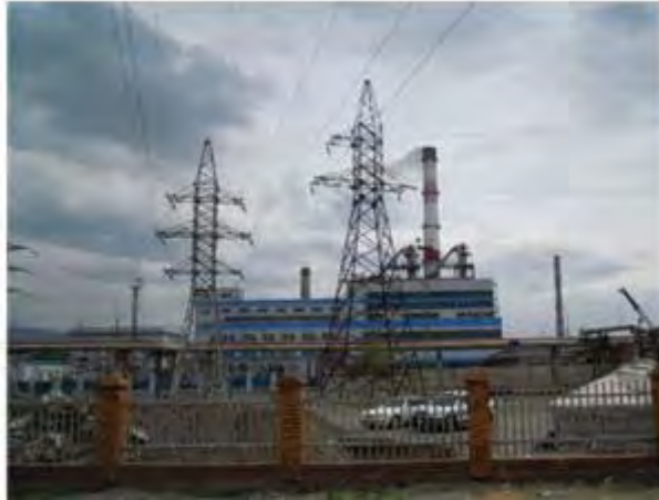
図 4-2 発電所全景 煙突：120m（左側の煙突 80m は使用していない）
