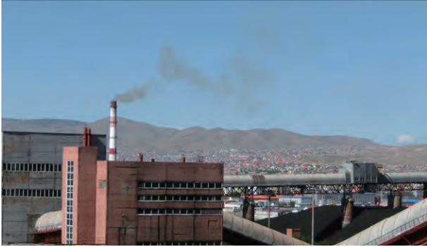
火力発電所 No. 2
