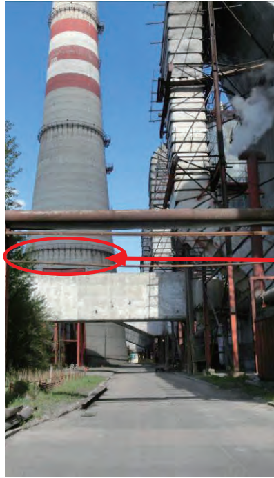
連続排ガス監視システム (CEMS) を設置する場合は矢印の位置に設置
