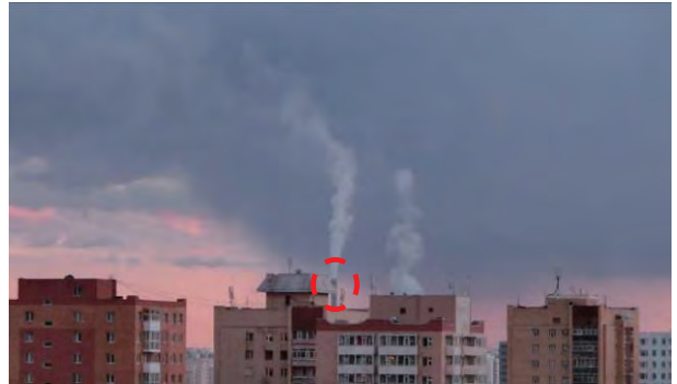
火力発電所 No. 3
