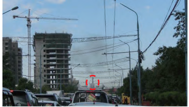
火力発電所 No. 2
