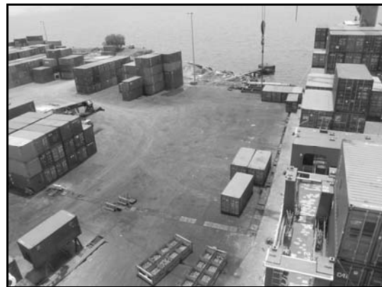
写真-4 国際埠頭岸壁の状況
