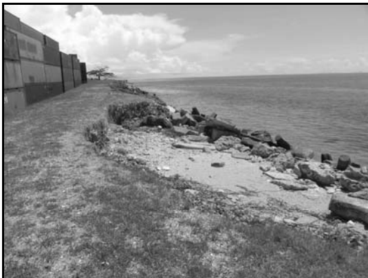
写真-23 第二国際埠頭の建設サイトの状況
