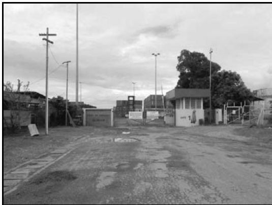
写真-3 港湾ゲート（入口）
