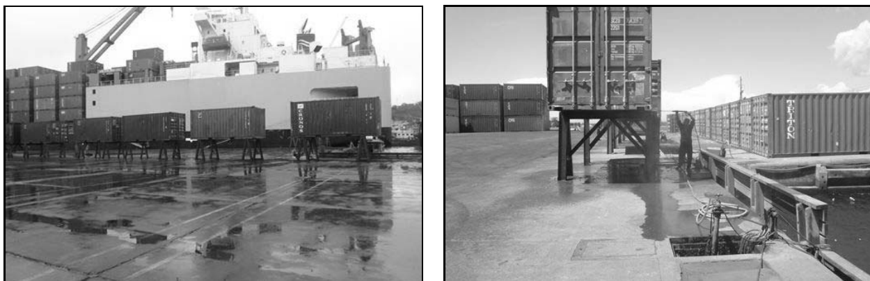
写 2.2.2-4 Container Washing Bridge と洗浄作業の状況
