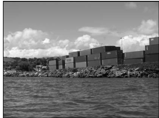
写真-20 第二国際埠頭の建設サイトの状況
