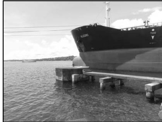
写真-8 岸壁東側のドルフィン
