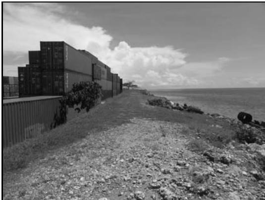
写真-21 第二国際埠頭の建設サイトの状況
