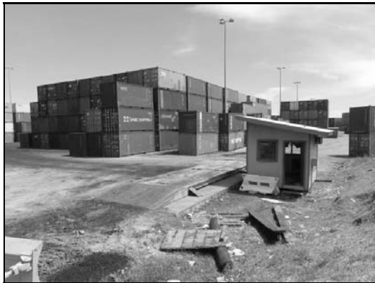
写真-19 コンテナ計量施設の状況
