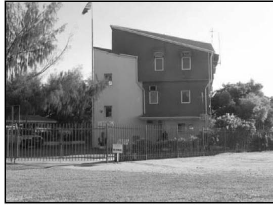
写真-2 港長事務所棟
