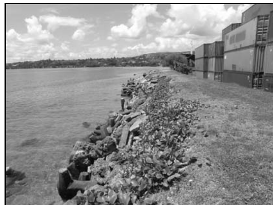
写真-22 第二国際埠頭の建設サイトの状況
