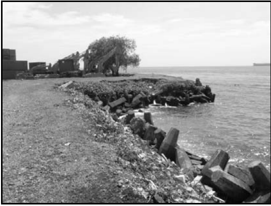
写真-25 国際埠頭東側の護岸の状況
