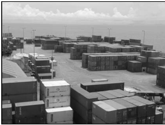
写真-11 コンテナヤードの状況
