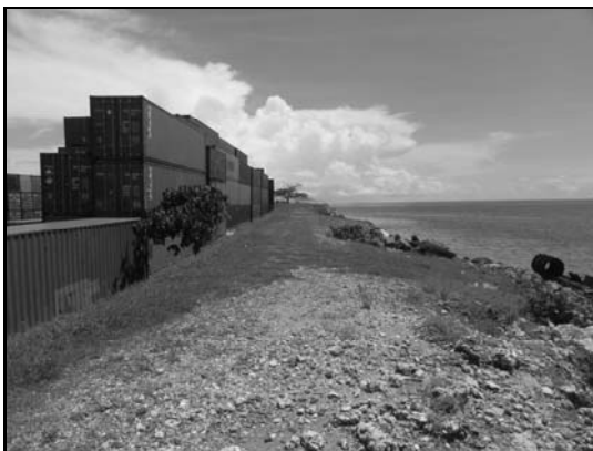
写真-21 第二国際埠頭の建設サイトの状況
