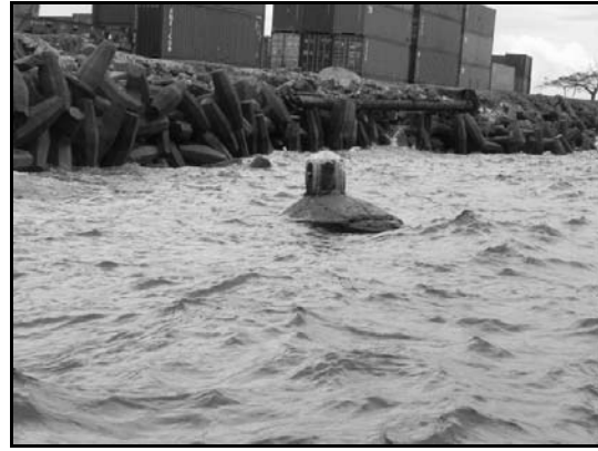
写真-26 東側護岸沖のボラードの状況
