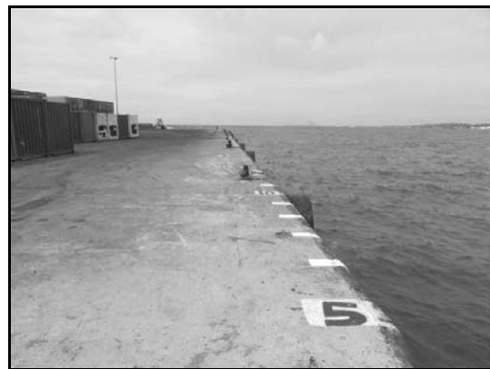
写真-6 国際埠頭岸壁エプロンの状況
