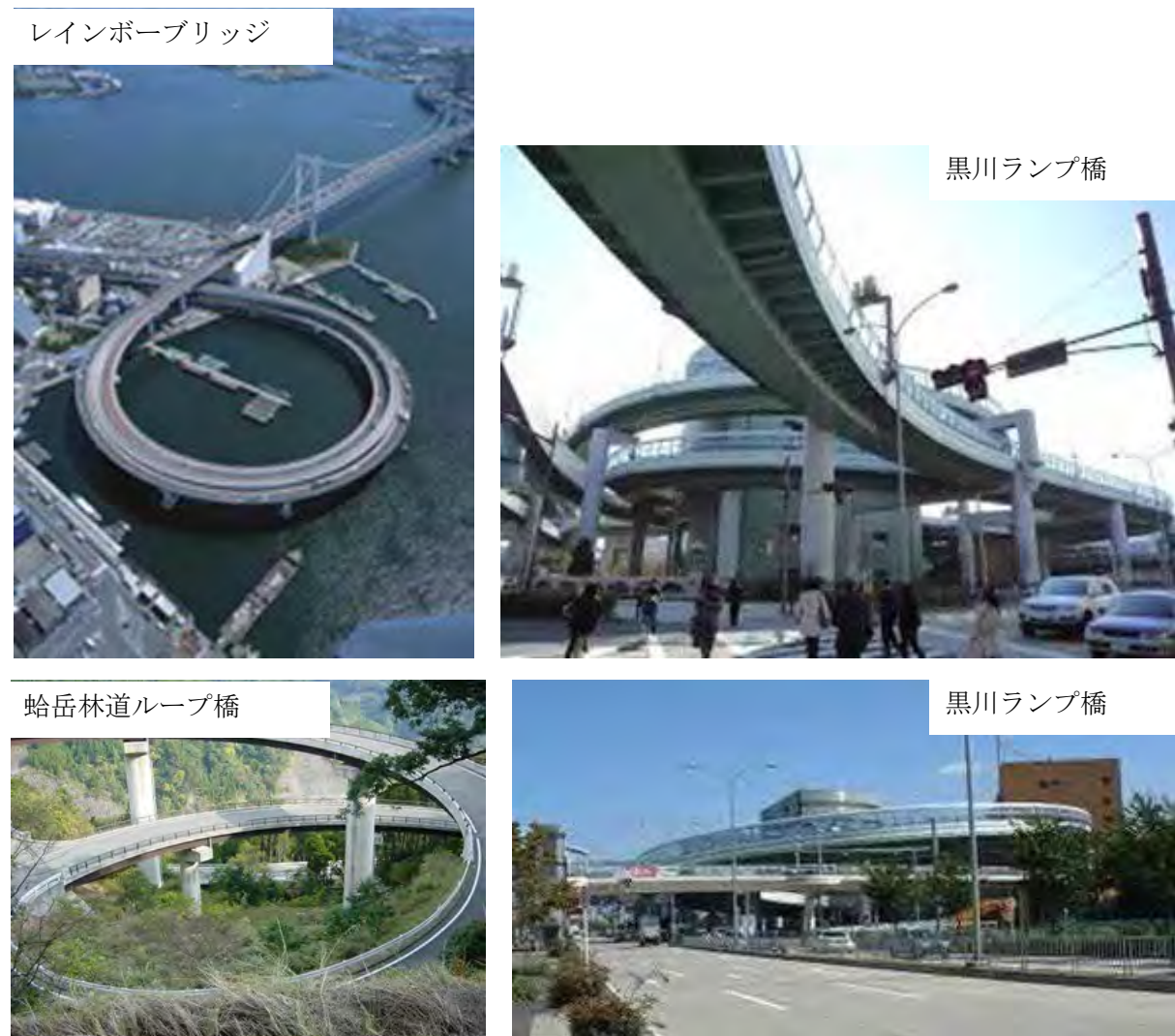
図 5. 2. 41 ループ橋の施工事例
