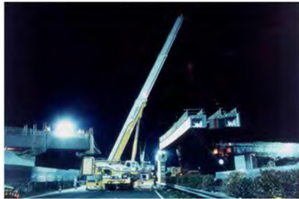
図 5.2.39 主桁施工事例
