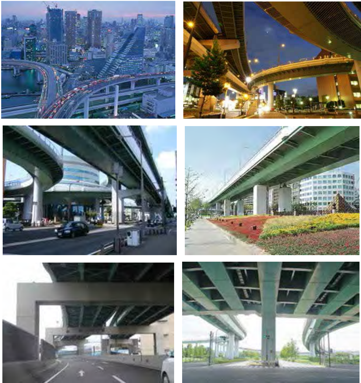
図 5. 2. 40 橋梁施工完成後の事例
