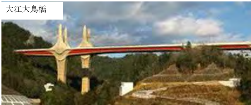
図 5.2.36 エクストラロード橋の施工事例
