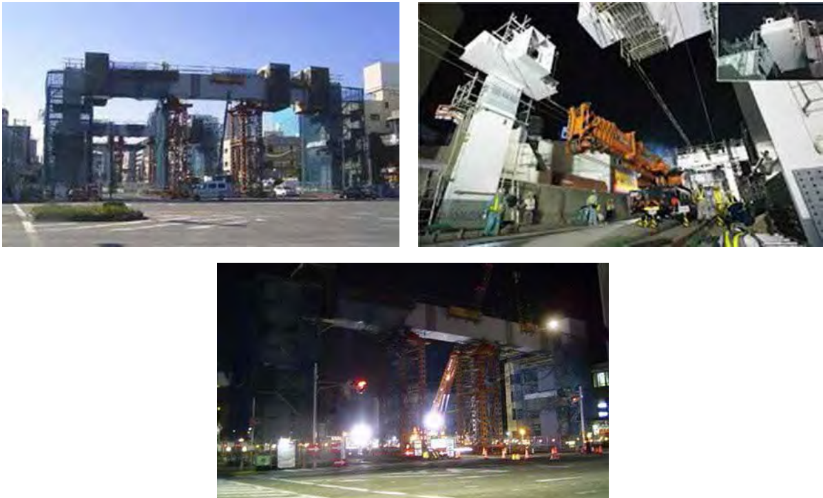
図 5.2.38 鋼製橋脚および主桁の施工事例
