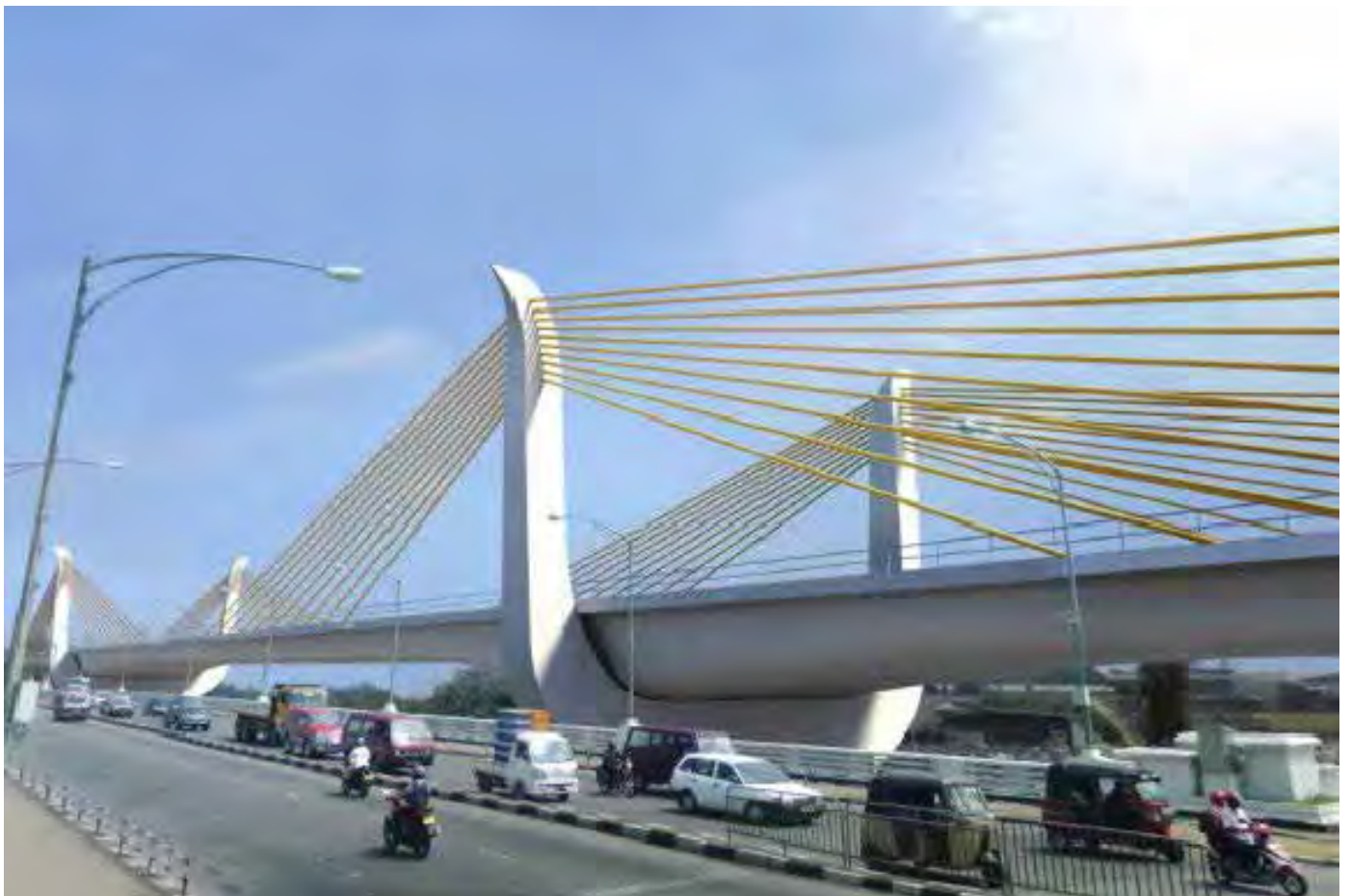
既設橋から見た主橋梁
