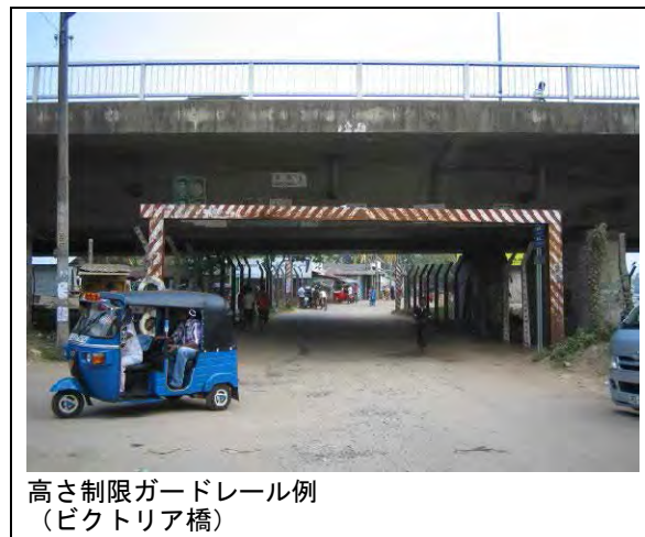
図 2.4.11 高さ制限ガードレールの例
