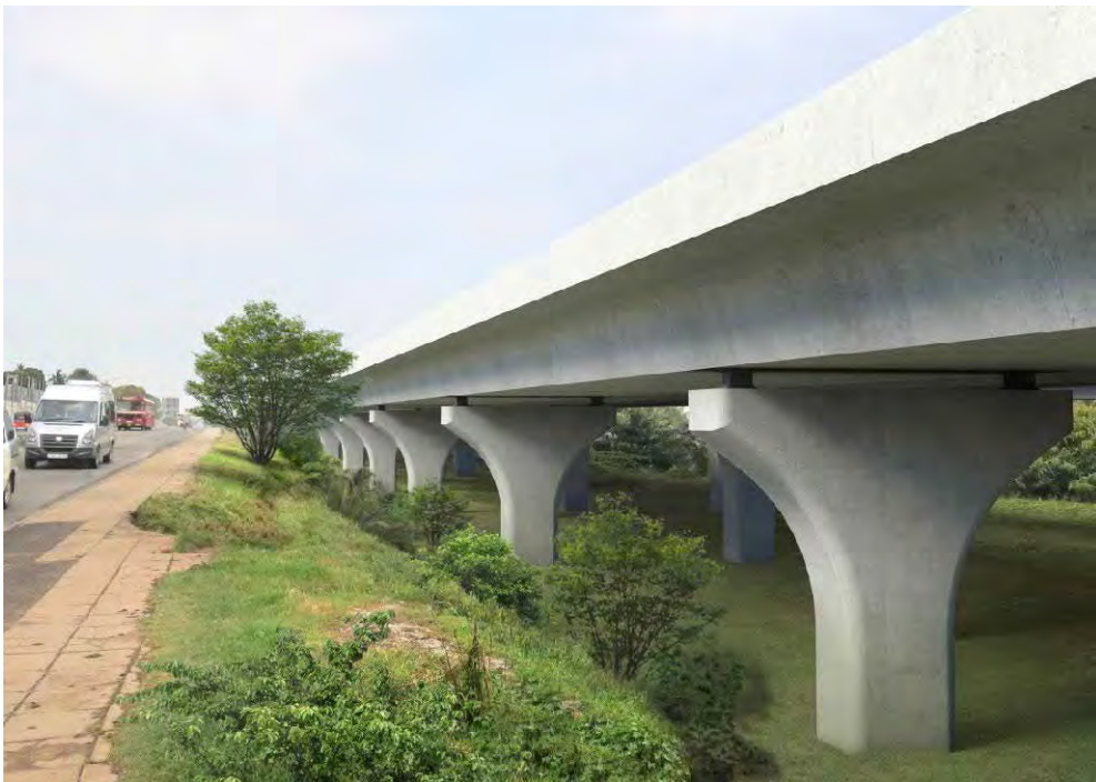
図 S5. 2. 3 既設道路から見たアプローチ橋 (PC 箱桁橋)
