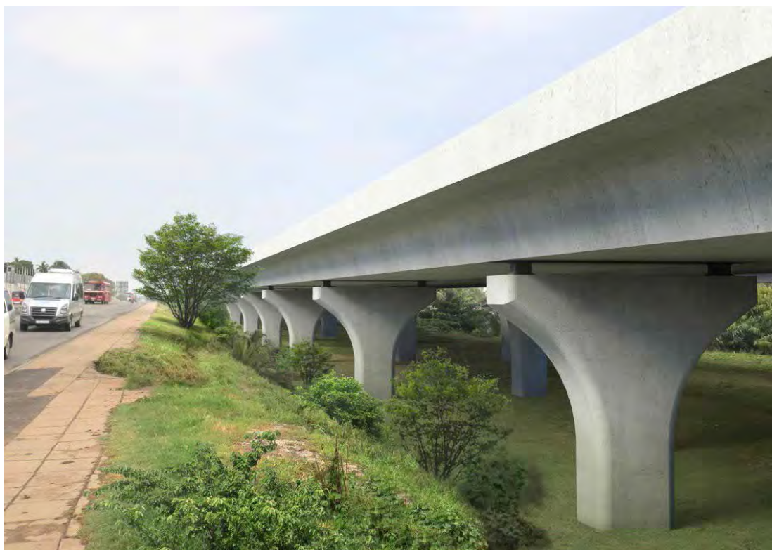
既設道路から見たアプローチ橋（PC箱桁橋）
