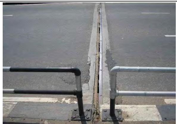
同、下流側 伸縮継手は原型を保っている。
