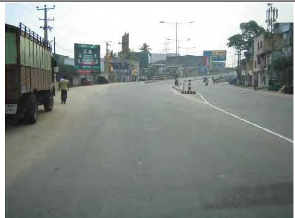
Avisawella road, フライオーバー終点付近 Good condition
