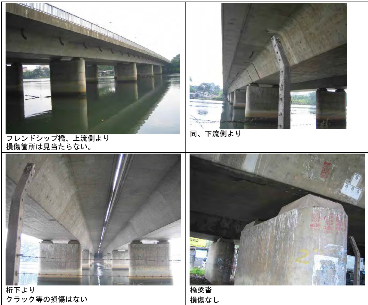
図 2.4.9 その他橋梁の状況
