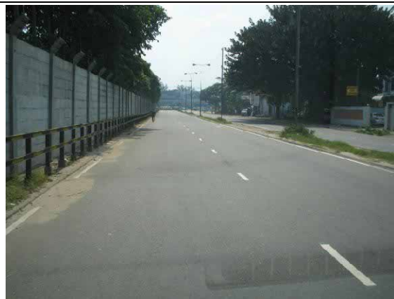
New Kelani Bridge road ポットホール、クラックはなくスムーズな表面
