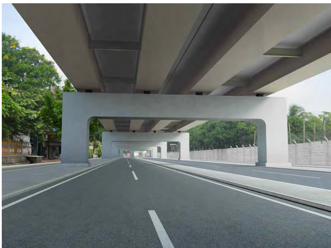
既設道路から見たアプローチ橋（鋼箱桁橋）
