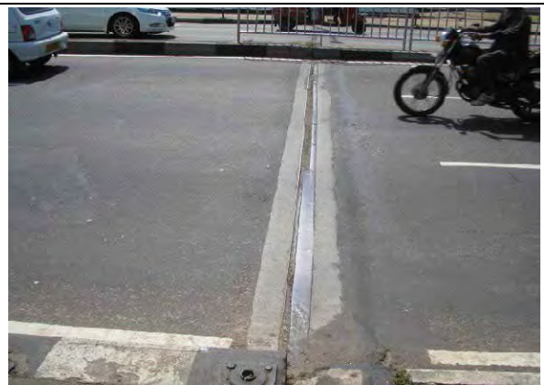
A1 下流側伸縮継手 かなり原型を保っている。
