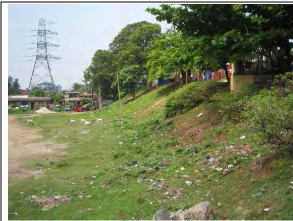
盛土部斜面 コロンボ、上流側
