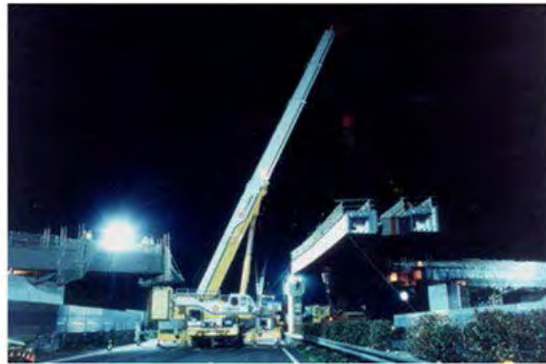
図 5. 2. 39 主桁施工事例
