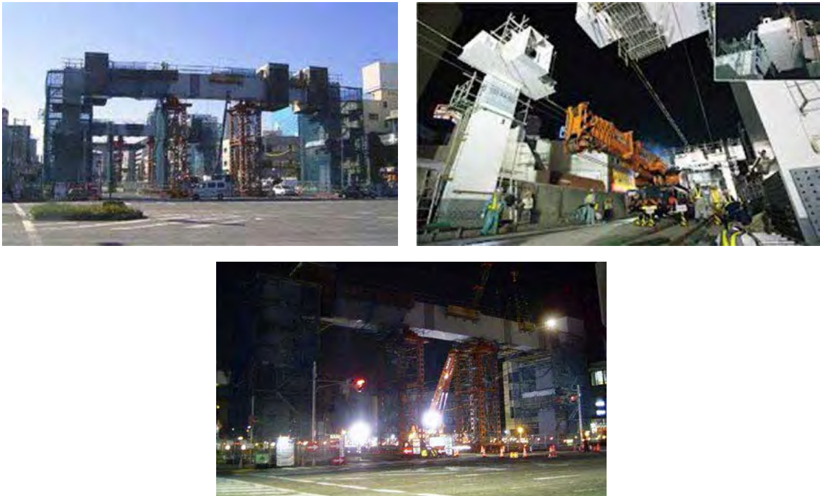
図 5.2.38 鋼製橋脚および主桁の施工事例
