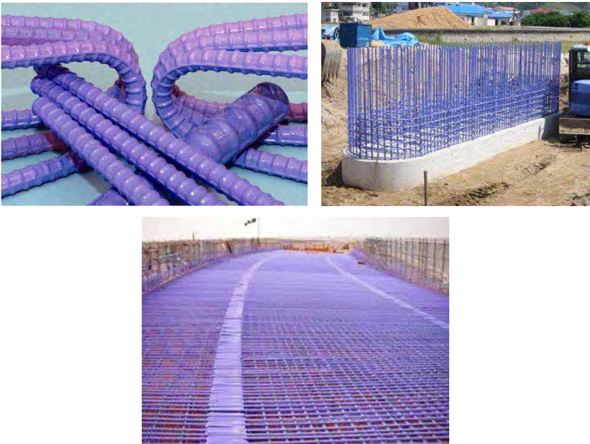
図 5.2.43 エポキシ鉄筋の施工事例
