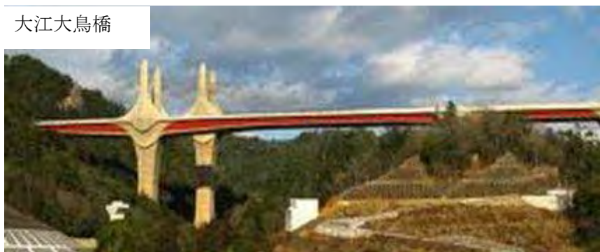
図 5. 2. 36 エクストラロード橋の施工事例
