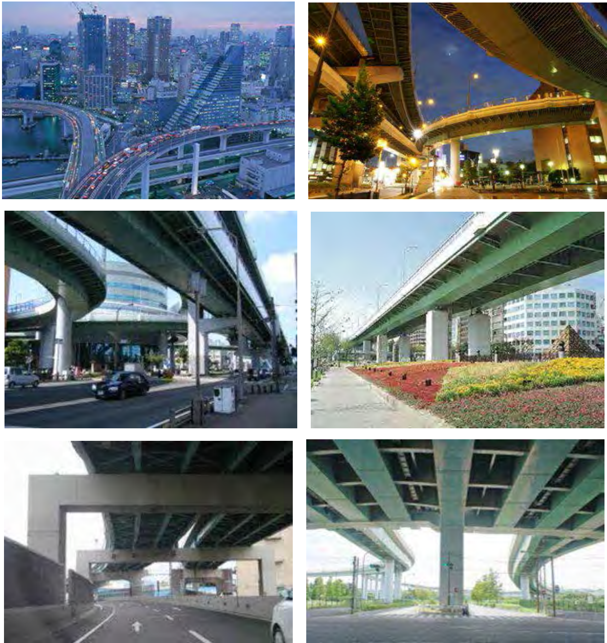
図 5. 2. 40 橋梁施工完成後の事例
