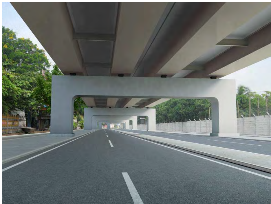
図 5.2.34 既存道路から見た鋼箱桁橋
