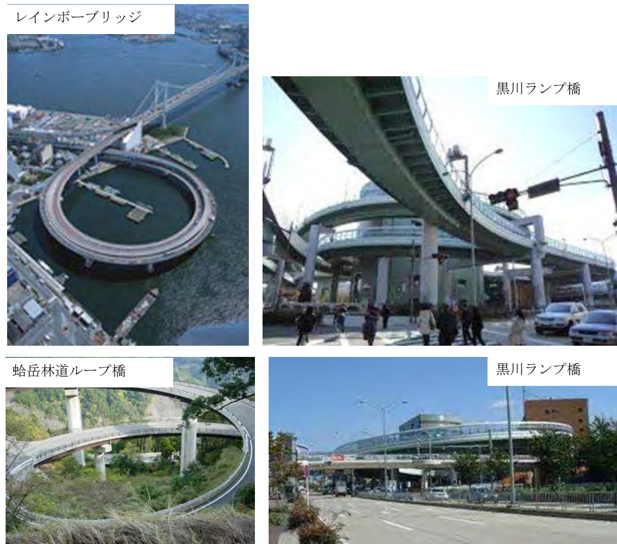
図 5. 2. 41 ループ橋の施工事例
