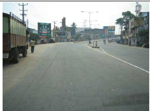
Avissawella road, フライオーバー終点付近 Good condition
