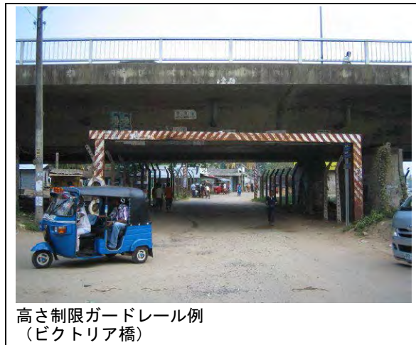
図 2.4.11 高さ制限ガードレールの例
