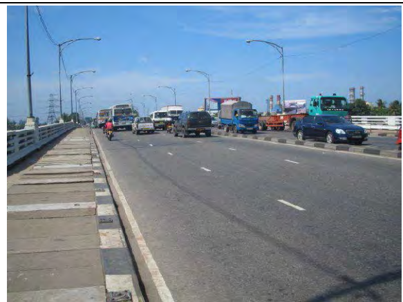
橋面舗装状態 全般的に良好である。
