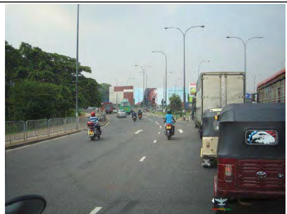
Waragoda 交差点付近 左側レーンは Base Line road クラックなし。
