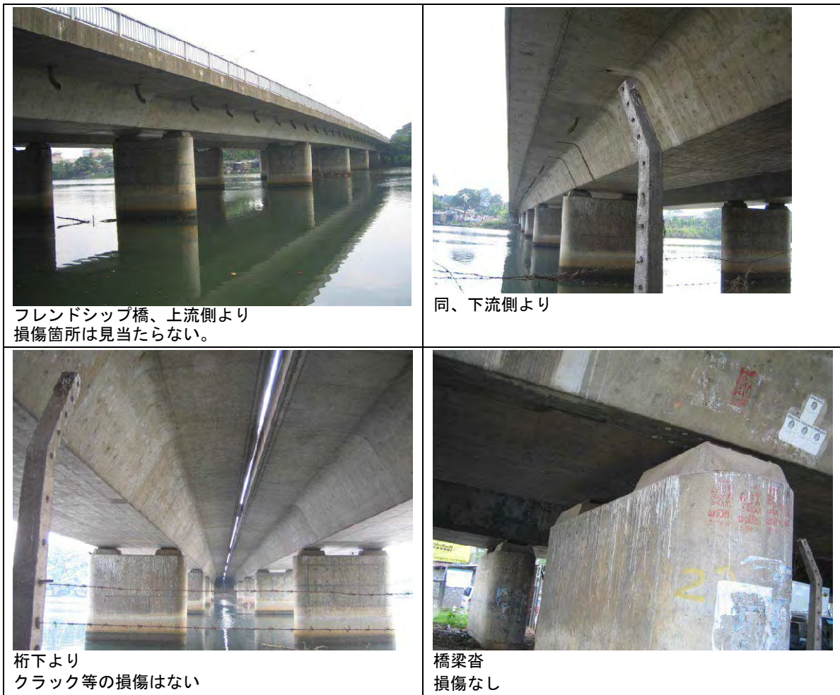
図 2.4.9 その他橋梁の状況
