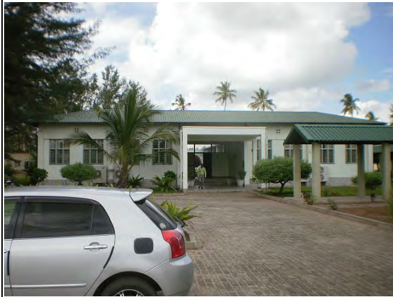
写真 9: ICS キリマネ外観 我が国の無償資金協力により 2007 年に竣工した「モ」国中部ザンベジア州にある ICS。状態はおおむね良好である。
