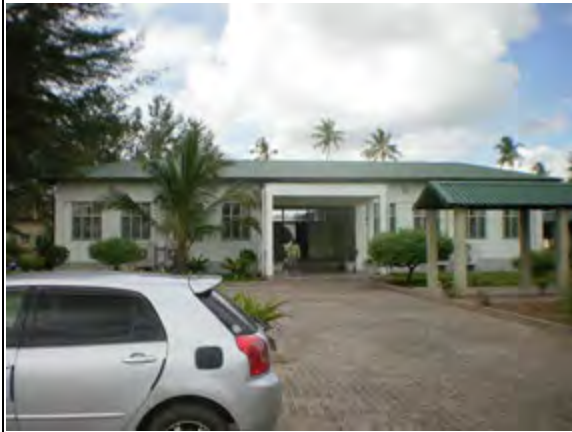
写真 9: ICS キリマネ外観 我が国の無償資金協力により 2007 年に竣工した「モ」国中部ザンベジア州にある ICS。状態はおおむね良好である。
