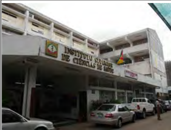
写真 1: 既存 ICSM 外観 マプト市の中心部に位置し、中央病院に隣接する。上級医療従事者養成学校と施設を共用している。
