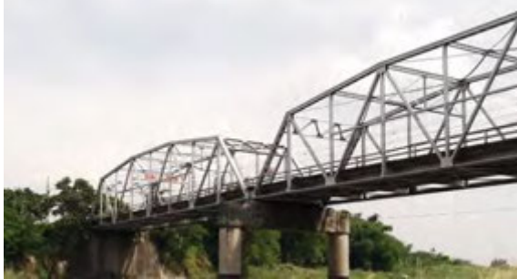
C05 Sicsican Bridge
