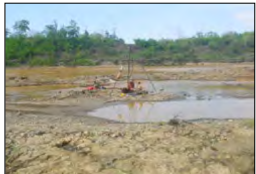
写真 2-2-4 BH4 ボーリング調査状況
