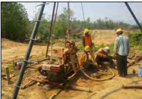
写真 2-2-3 BH2 ボーリング調査状況
