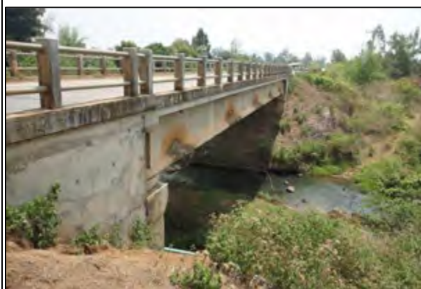
写真-15：日本の無償資金援助により架けられた橋
