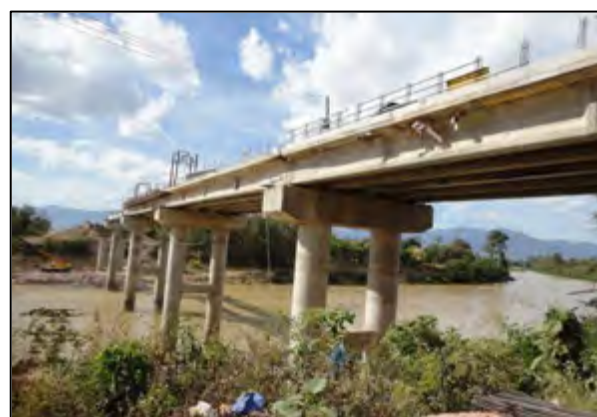
写真-16：日本とラオス国の基金により建設中の橋
