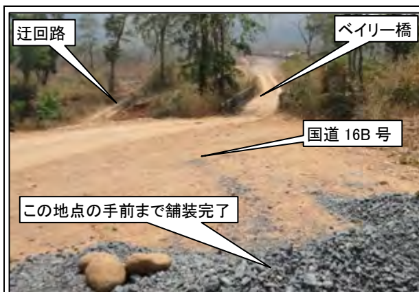
写真-9：国道 16B 号の工事進捗状況
