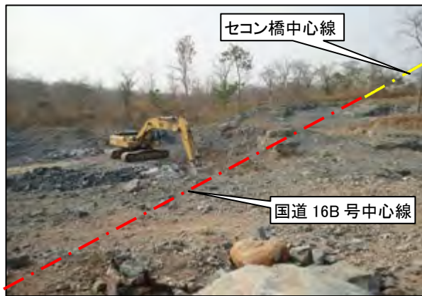
写真-3 : 工事中の国道 16B 号
