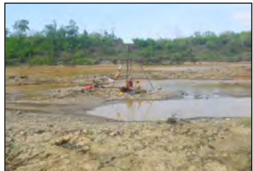
写真 2-2-4 BH4 ボーリング調査状況
