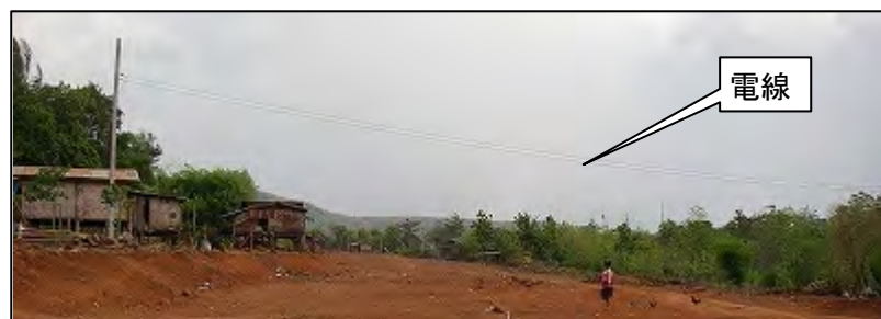
図 2-2-1 工事中に支障となる電線
