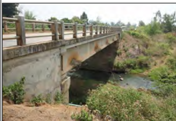
写真-15：日本の無償資金援助により架けられた橋
