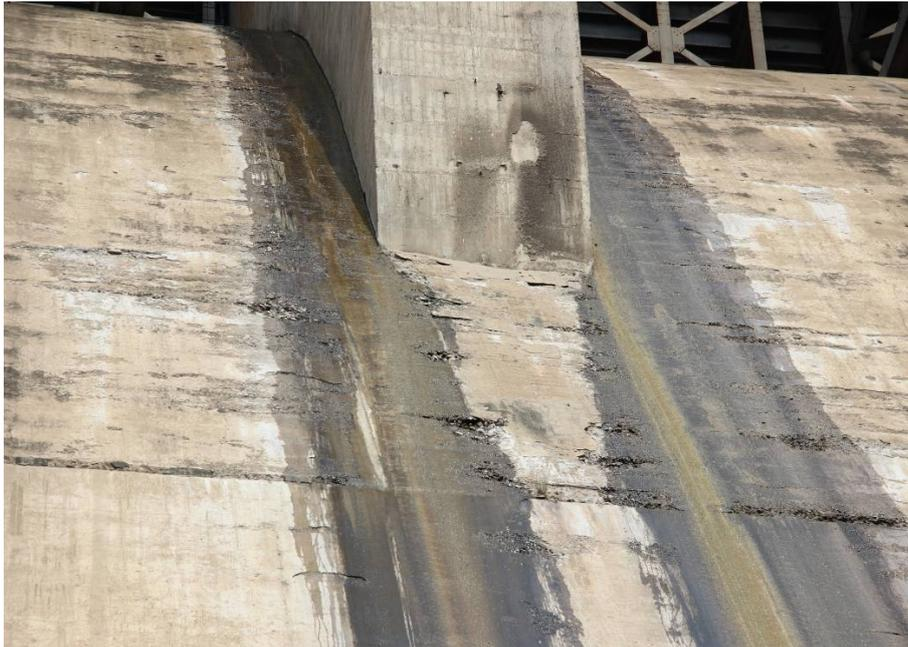
大坝溢流面剥蚀破坏情况照片
