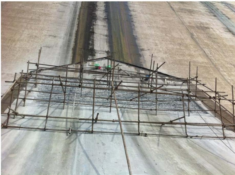
钻  $\phi 22$  的孔, 然后插入  $\phi 18$  的螺纹钢, 插筋间距为 50cm, 用专用的植筋胶锚固, 插筋之间的绑扎用  $\phi 8$  的圆钢, 混凝土保护层厚度大于 5cm。
