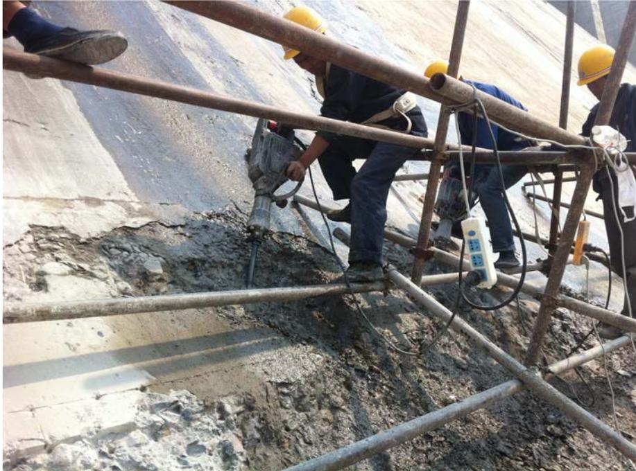
凿除剥蚀或脱空的混凝土,深度大于 10cm; 高压水清洗基面,使其表面没有残杂和浮尘。
