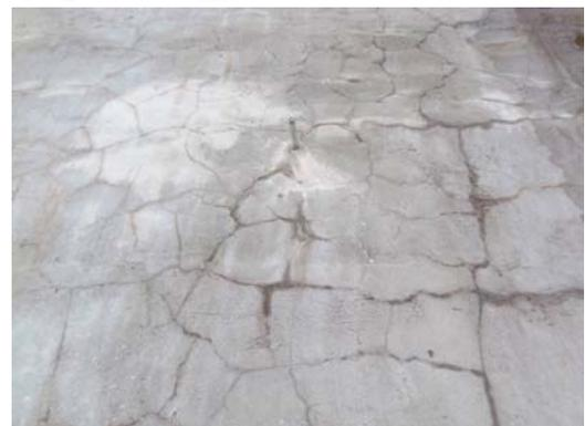
发生龟甲纹状裂缝的施工面的状况
