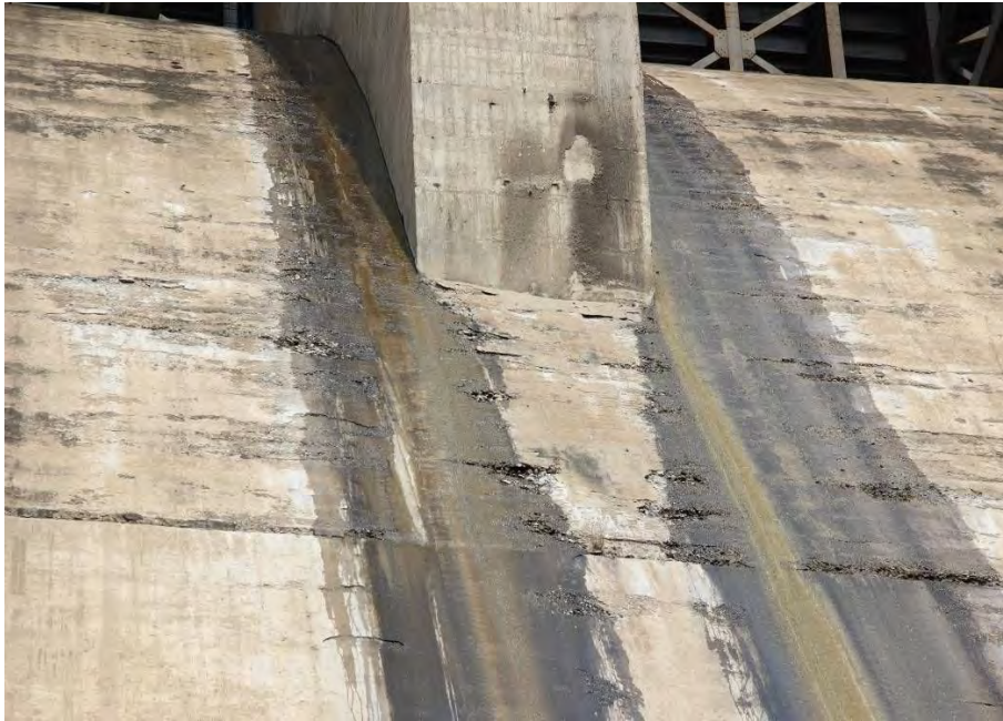
ダム越流面の剥離破壊状況
