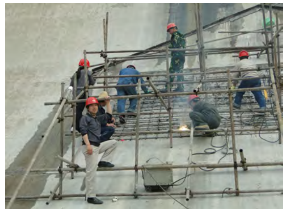
ポリ尿素による表面被覆工による補修工事
