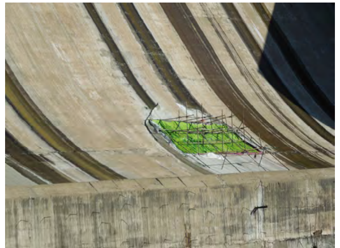
モルタルを左官工法で塗りつけて養生
