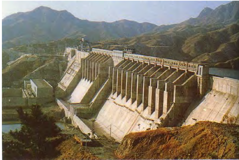
潘家口ダム下流側全景
