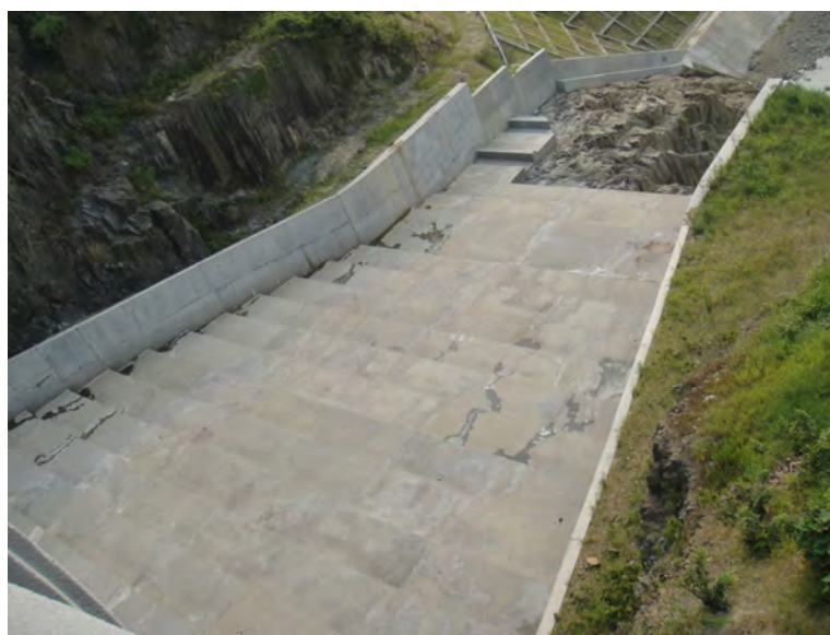
陸埠ダム洪水吐下流部
