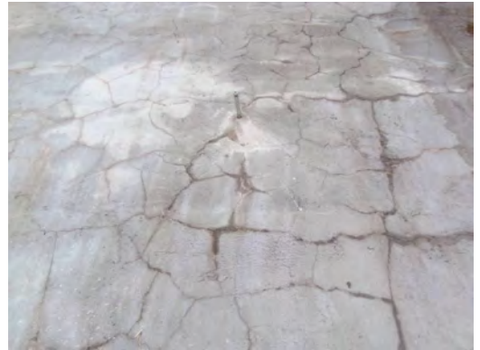
亀甲型の亀裂が発生した施工面の状況
