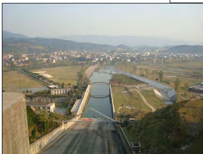
六都寨ダム洪水吐下流面
