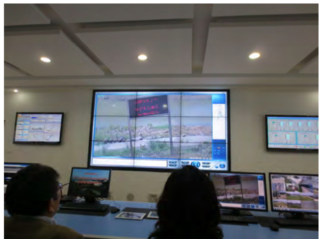
中央監視室からのモニタリング状況
