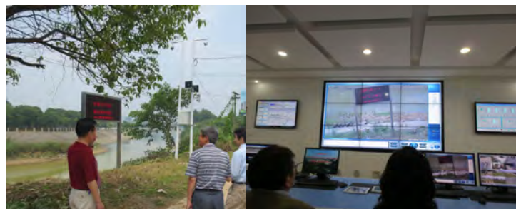
陸水ダムの下流警報システム
