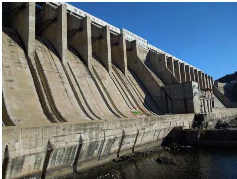
凍結融解対策の試行を実施したダム下流面
