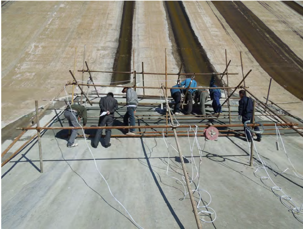
断面修復、NEXSUS を準備し、塗る。
