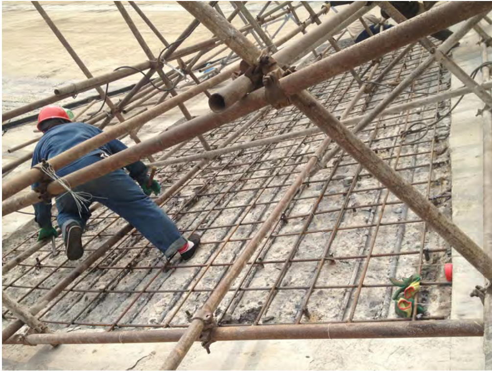
界面剤を塗り、ポリマーコンクリートを注入し、保湿養生14日。
