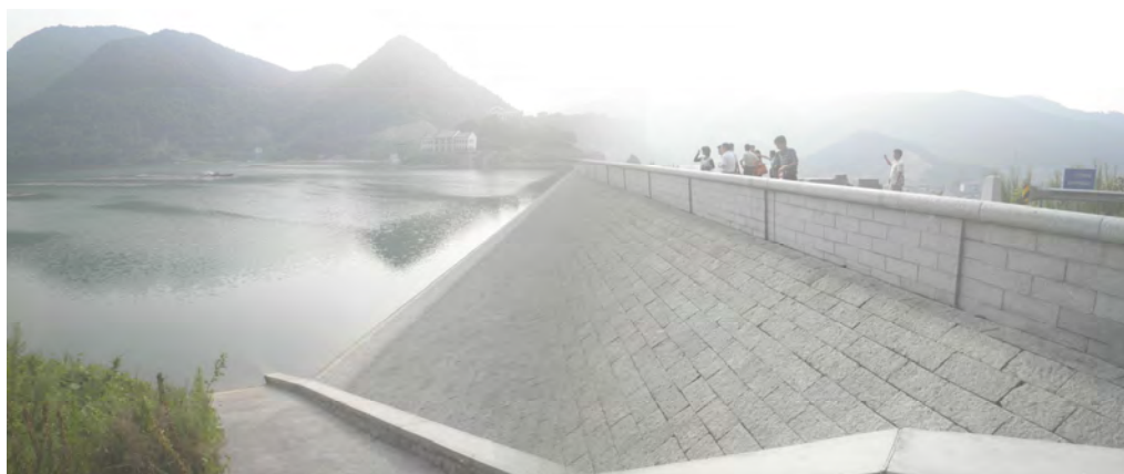
陸埠ダム堤体上流側
