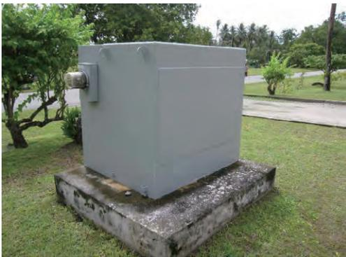
地上据置型送配電用変圧器
