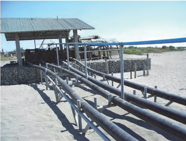
NIFTDC 給水施設
