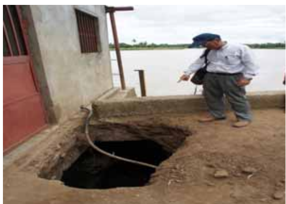
灌漑ポンプ設置小屋 (川側からの浸食により床下が空洞化)
