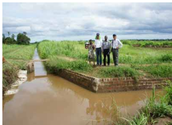
プロジェクトにより整備された導水路
