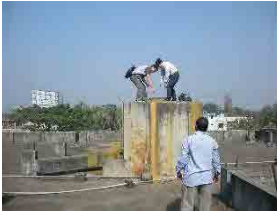
写真 3 : 住居貯水槽調査
