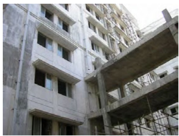
チェンナイ小児病院新入院棟：外観 現在建設中の新入院棟は、RC造地上10階建てであり、本館とは3階と4階に設けた渡り廊下で接続されている。
