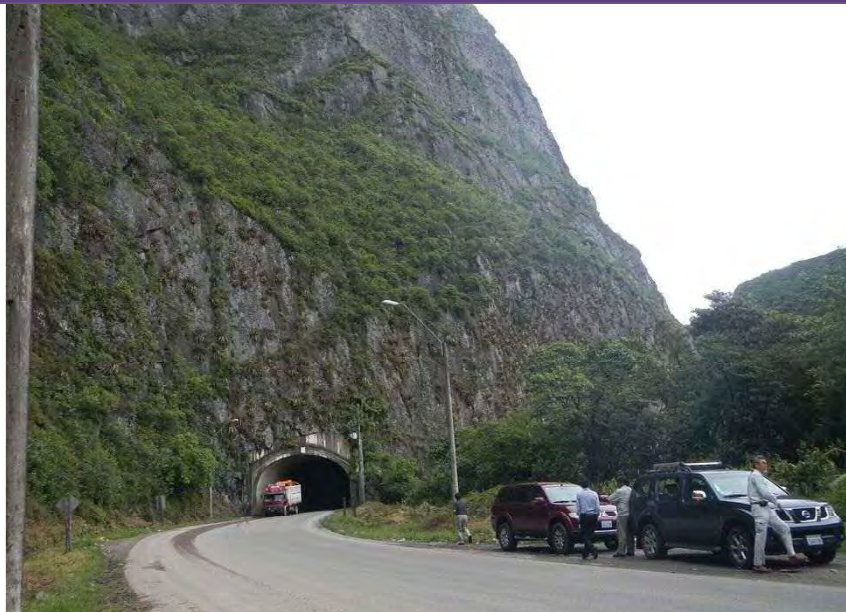
Túnel L=150 m (1970)
