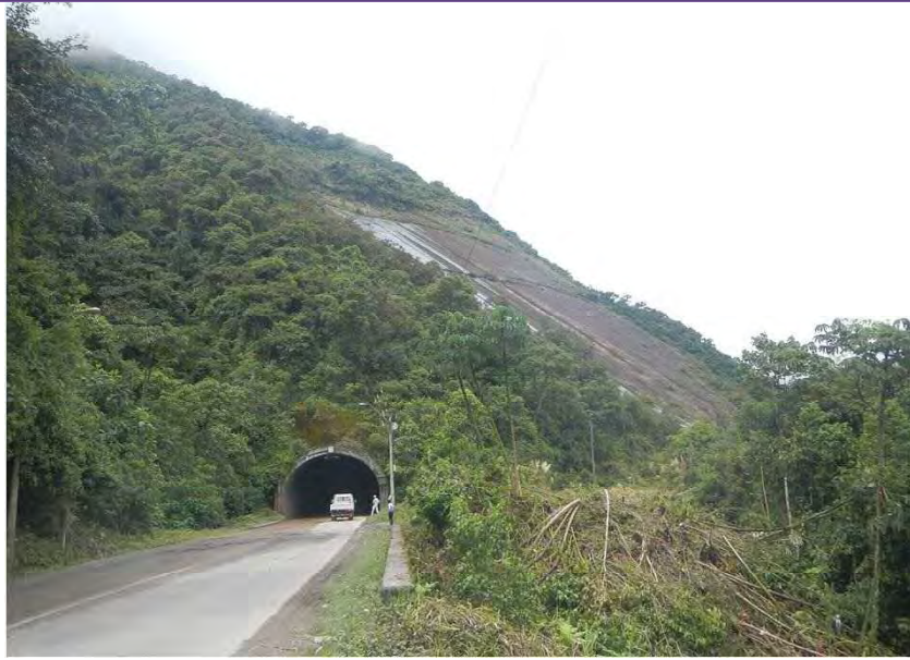
Túnel L=475 m (1970)
