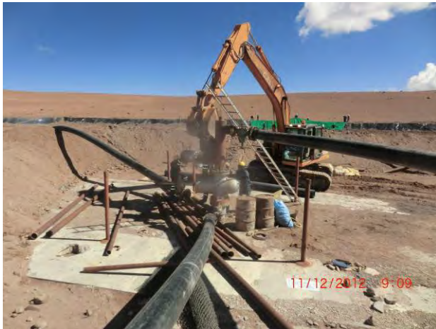
Instalación de tubería en el cabezal del pozo SM-4
