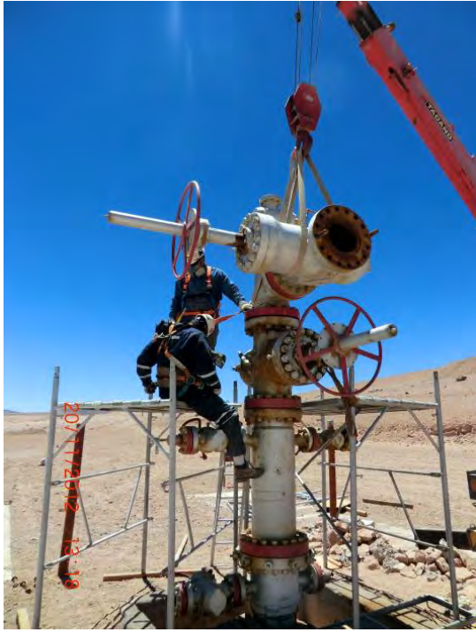
Instalación de la valvula lateral de pozo SM-2
