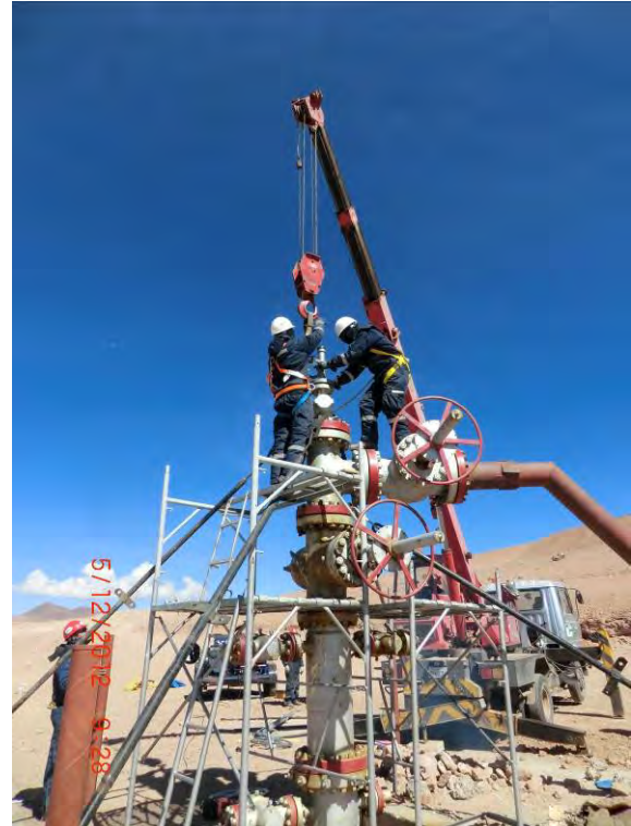
Armando la herramienta para el registro de PTS en el pozo SM-1
