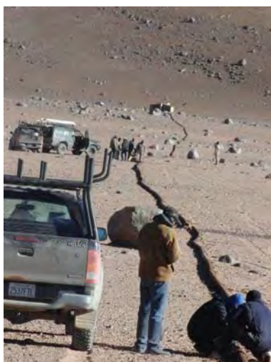
Reparación de tubería de agua
