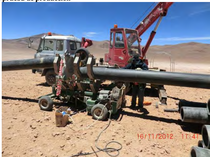
Instalación del tubería de HDPE de 12"
