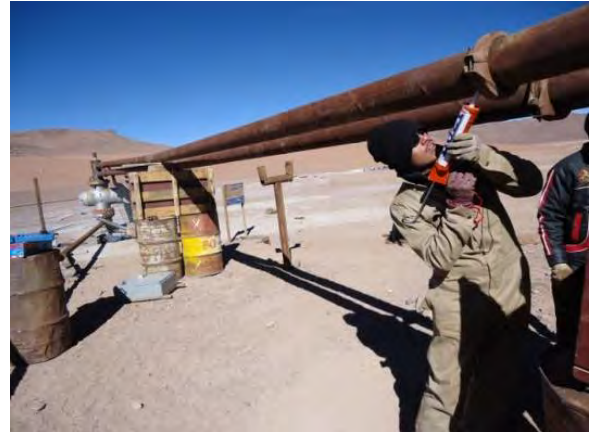
Reparación de tubería de la fosa
