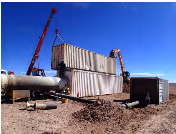
Construcción del equipo para la prueba de producción en el pozo SM-2
