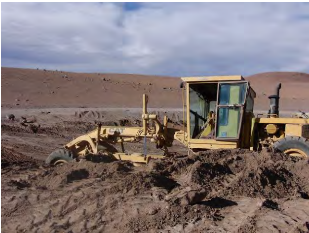
Construcción del fosa para el pozo SM-5
