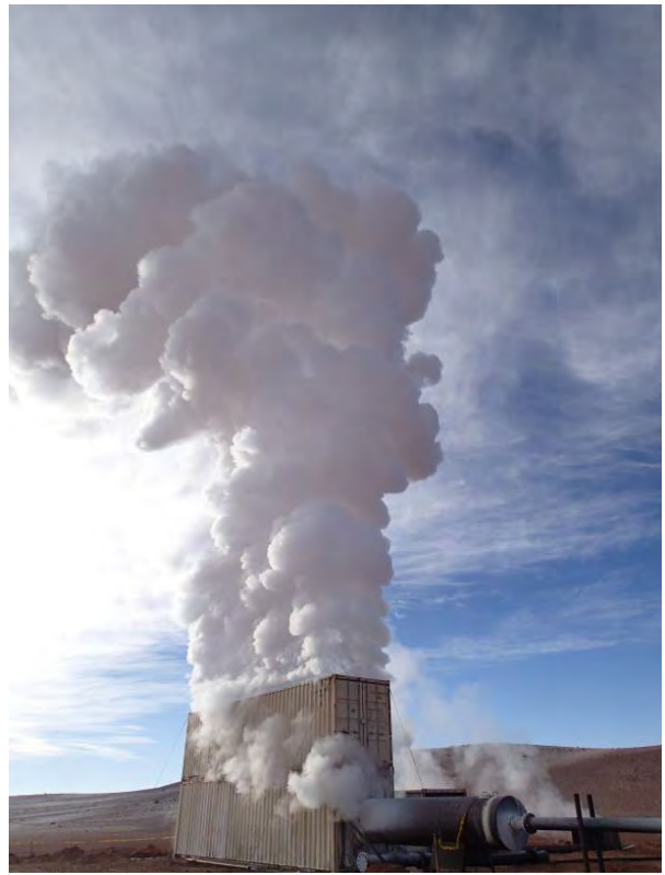
El pozo SM-3 durante la prueba de producción
