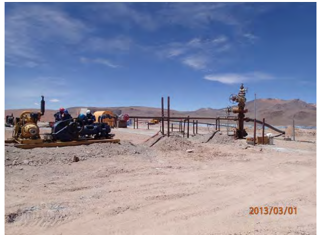
Eliminación del encrustación del cabezal en el pozo SM-2
