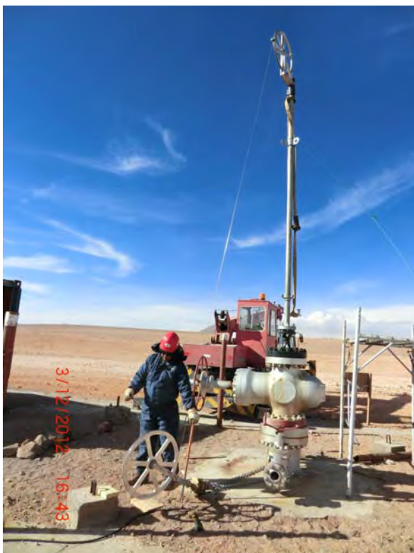
Pozo SM-3 durante el registro estatica de PTS
