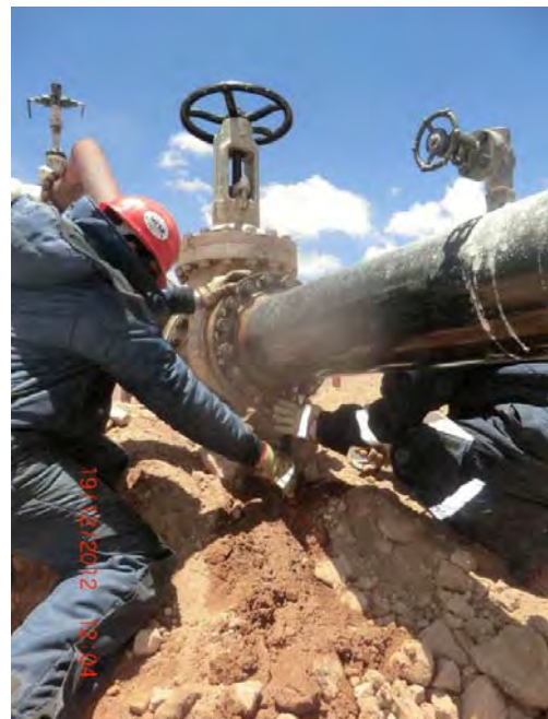
Intercambio del orificio para el control de flujo
