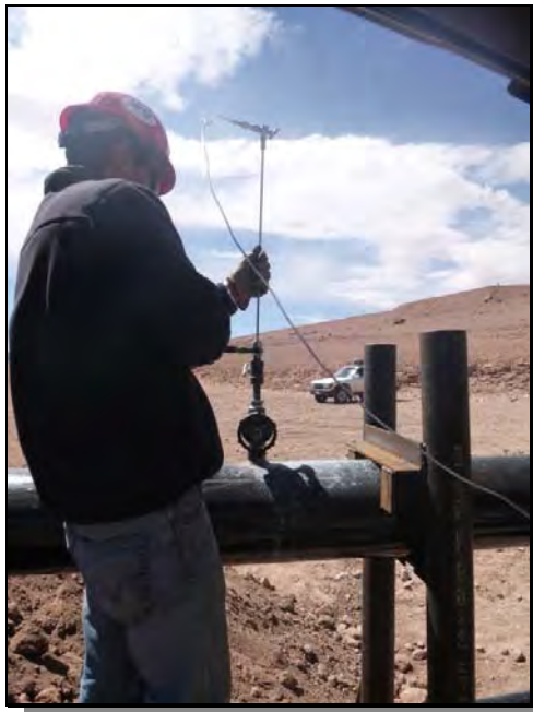
Figura 3: Instalación de ballesta para inyección de trazadores.
