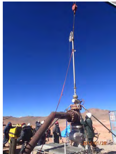
Recuperación del tubo capilar en el pozo SM-3
