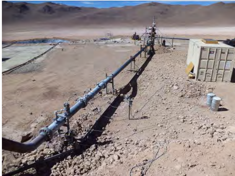
Instalación de tuberías para la prueba de producción en el pozo SM-1
