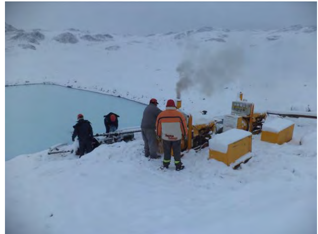
Transportación de agua desde la fosa de pozo SM-1 a fosa de pozo SM-5
