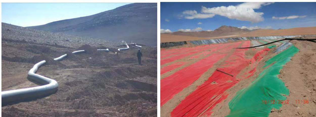
Figura 4-23 (izquierda) Fosa de respaldo, tubería de HDPE de 12 pulgadas entre el pozo SM-1 y el pozo SM-4 (en uso) (derecha) excavada cerca del pozo SM-4
