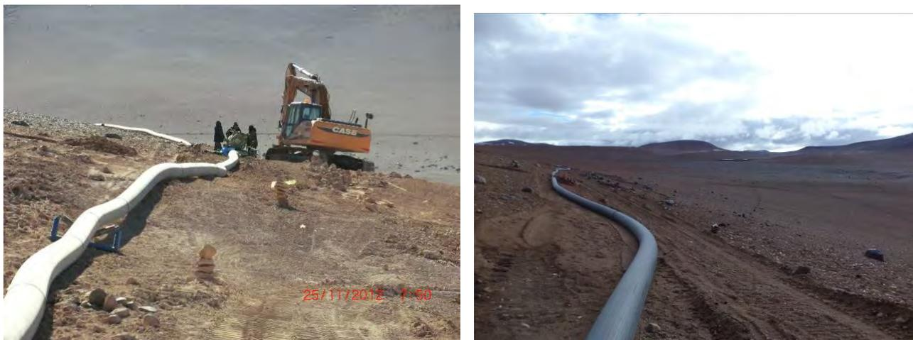
Figura 4-22 (izquierda) La construcción de la línea de tubería SM-4 -> SM-2 de 12 pulgadas de diámetro con tubo de polietileno de alta densidad (derecha) Tubería completa.
