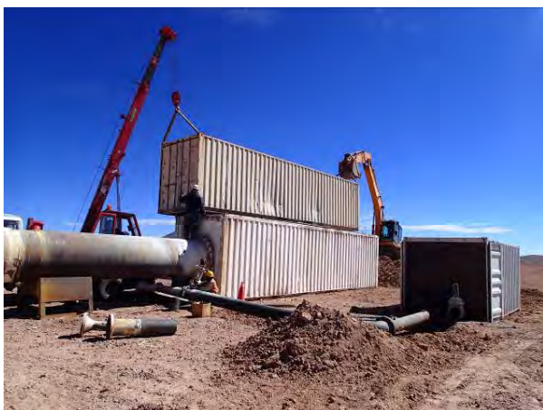
SM-2 の噴気試験装置(サイレンサー)の設営状況
