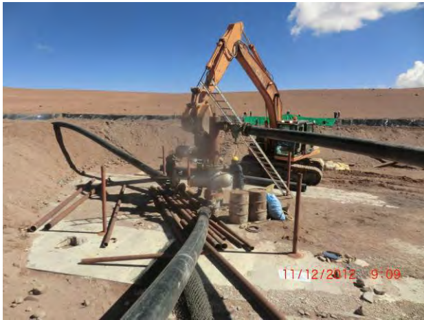
SM-4 の坑口配管の敷設作業中
