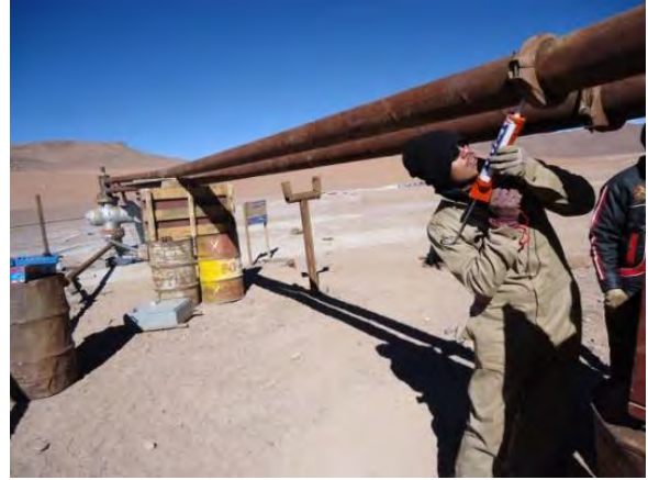
貯水池サイホン配管漏水処理
