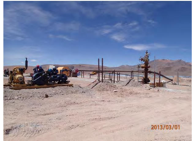
SM-2 の坑口装置のスケール除去工事
