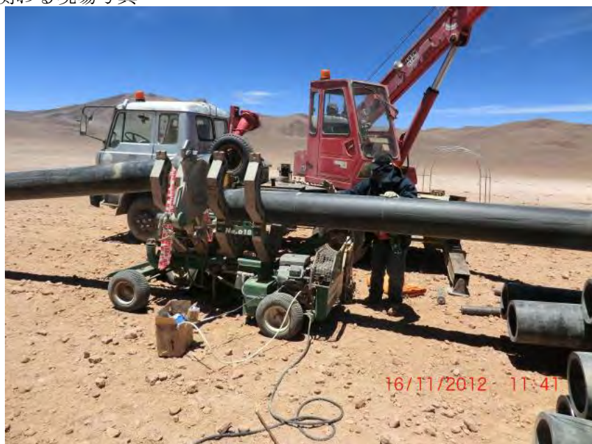
12 インチ HDPE 還元配管の敷設状況
