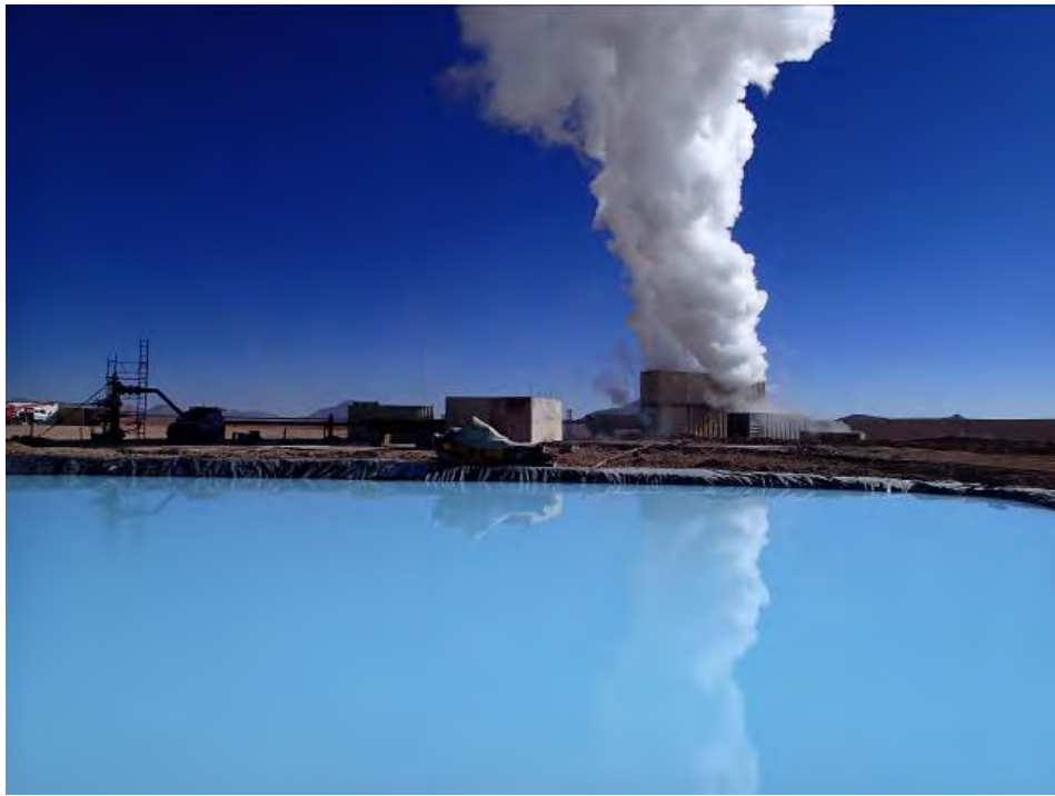
SM-2 の噴気試験状況(SM-2 側の貯水池越しに撮影)
