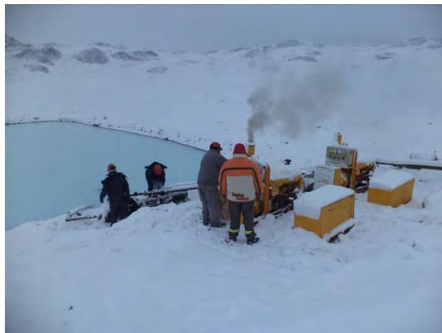
SM-1 の貯水池から SM-5 の貯水池への送水作業
