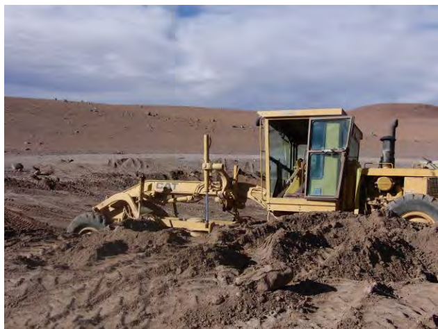
SM-5 横の貯水池の造成工事中
