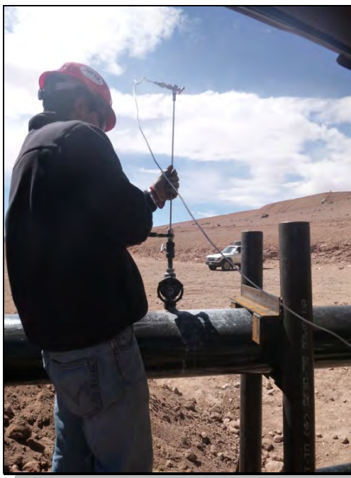
Figura 3: Instalación de ballesta para inyección de trazadores.
