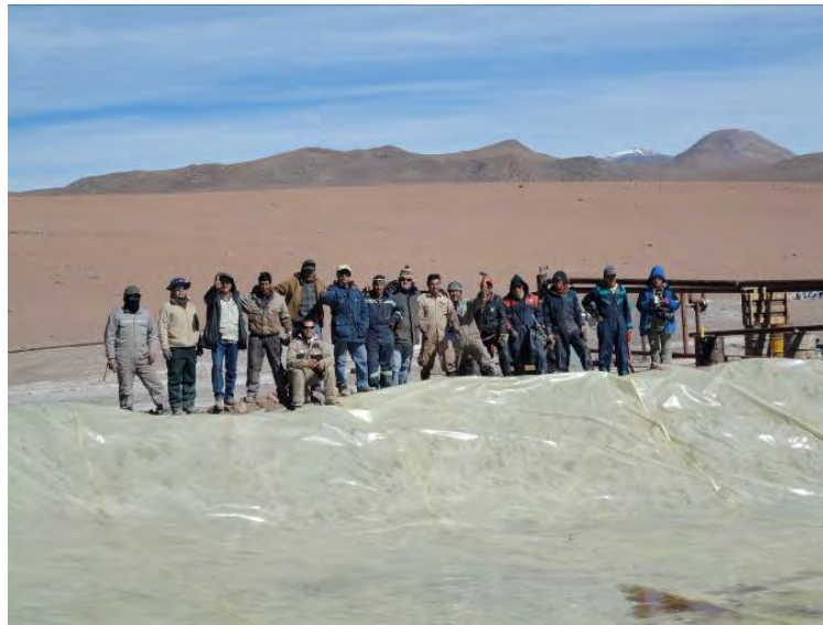
貯水池の造成完成時
