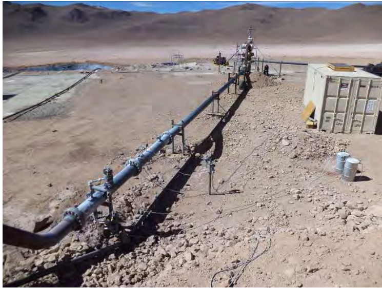
SM-1 噴気試験のフローライン設営状況
