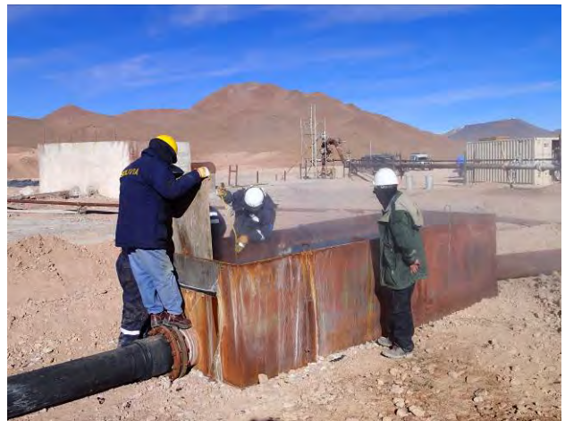
SM-2 の噴気試験における熱水堰の測定状況
