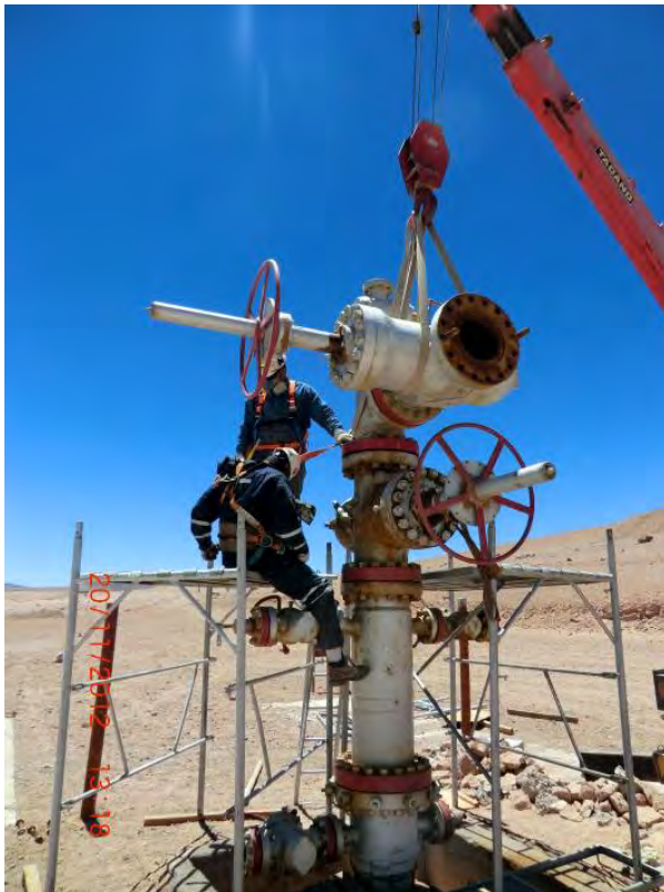
SM-2 におけるラテラルバルブの敷設状況
