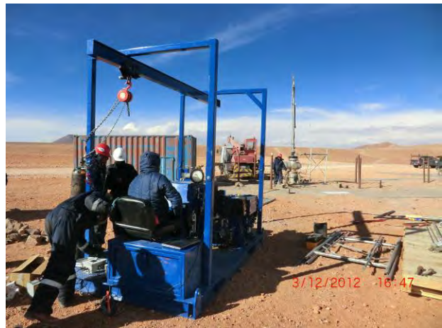
SM-3 におけるキャピラリーチューブの敷設
