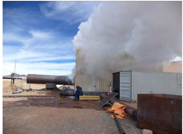
流量コントロール用オリフィスの交換作業状況
