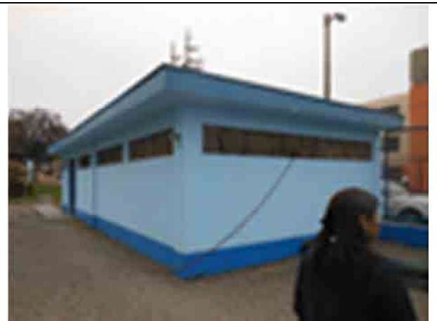
パイロットエリア2 (セクター67) 配水ポンプ場
