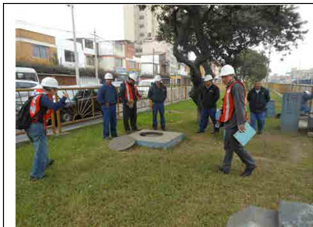
パイロットエリア1 (セクター18) 流入部チャンバー (流量計・水圧計等計器設置)
