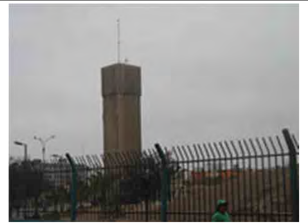
パイロットエリア2 (セクター67) 給水塔
