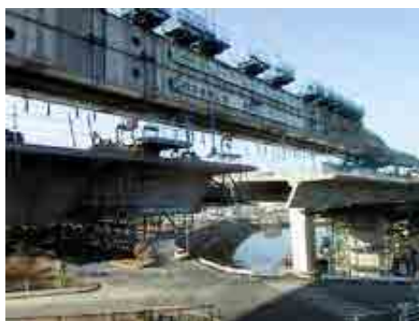
写真 5.1-1 スパンバイスパン工法による桁架設状況
