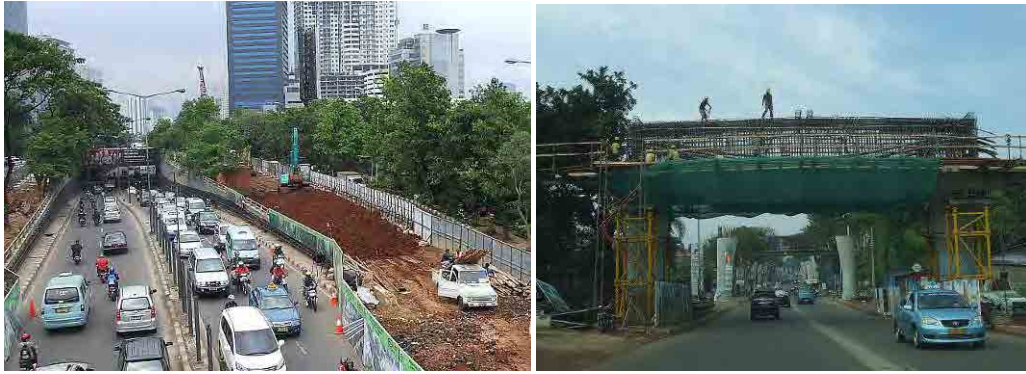
写真 3.1-1 Casablanca Flyover 建設状況と Pageran Antasari 付近 Toll Road 建設状況
