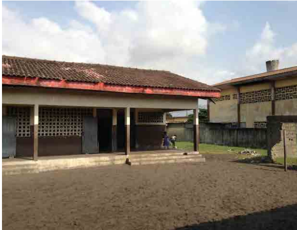
老朽化した(20年程度経過)アビジャン市内の小学校(躯体は意外としっかりしている)
