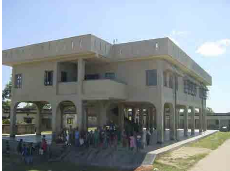
図 2-24 完成後のサイクロンシェルター
