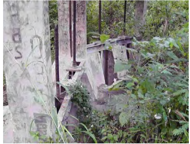
マリアナーII 灌漑の分水工 （堆砂が進行しており、灌漑取水は行われていない）
