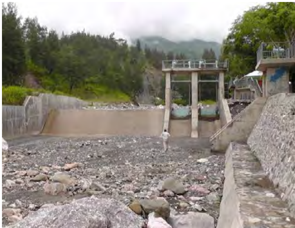
マリアナー I 灌漑地区の頭首工
