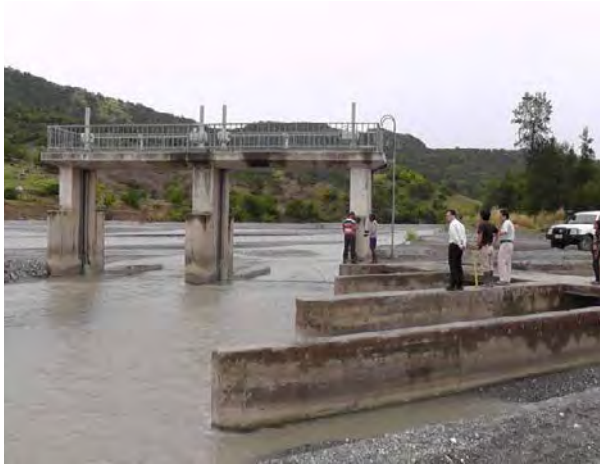
ラクロ灌漑頭首工と取水工（セミテクニカル） （手前は流入堆砂で埋まっている取水口）
