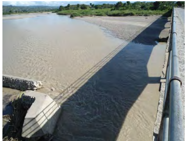
Seical 川下流国道橋 (Seical 川の河川流量観測を行う候補地として 提案される)
