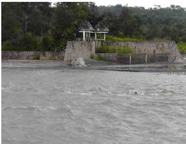
カラウルン灌漑地区取水工の対岸にあるボベ灌漑地 区の取水工（取水工のみ建設されており、導水は行 われていない）
