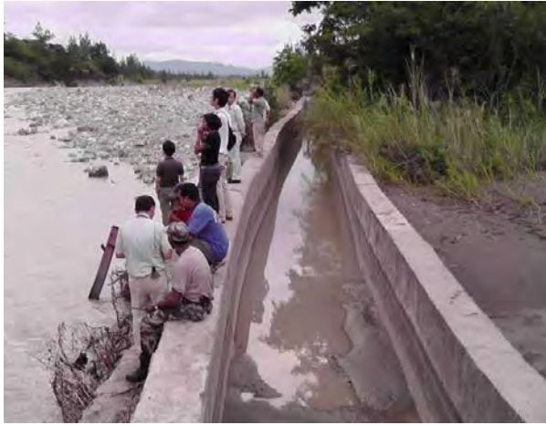
マリアナーII 灌漑の取水工（セミテクニカル） （取水口前の堆砂で使われなくなっている。 左側の対岸はインドネシア西ティモール領）
